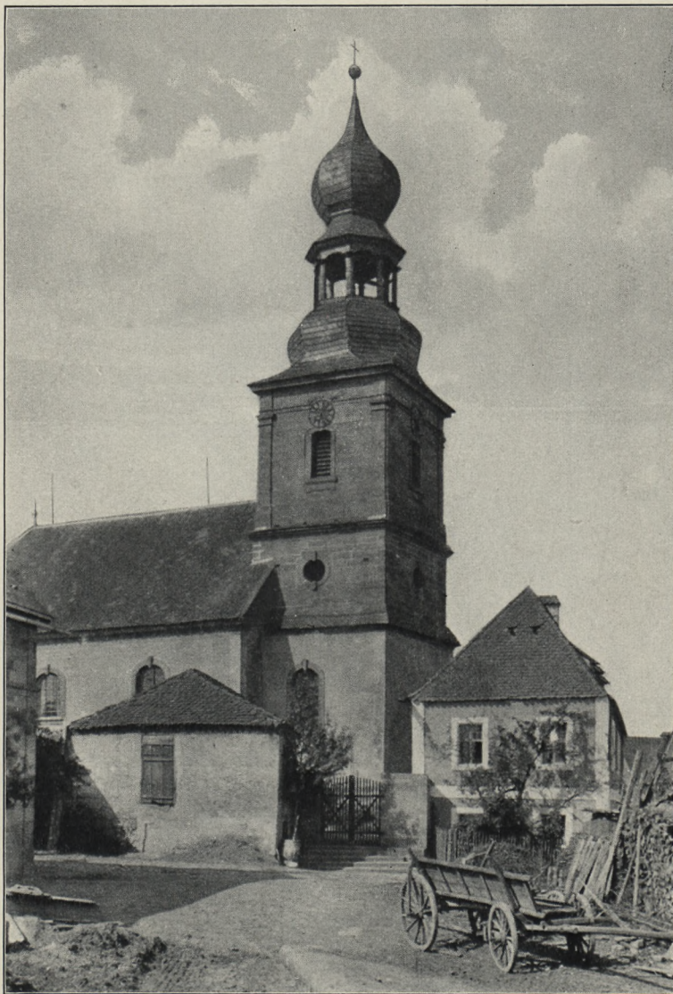
Fig. 85. Oberbibrach. Außenansicht der Kirche.
