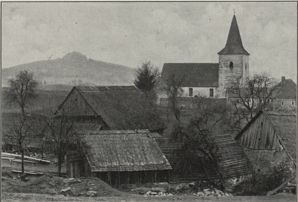
Fig. 21. Burkhardtsreuth. Südansicht der Kirche.
