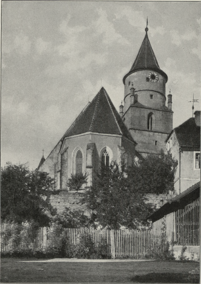
Fig. 28. Eschenbach. Ostansicht der Stadtpfarrkirche.
