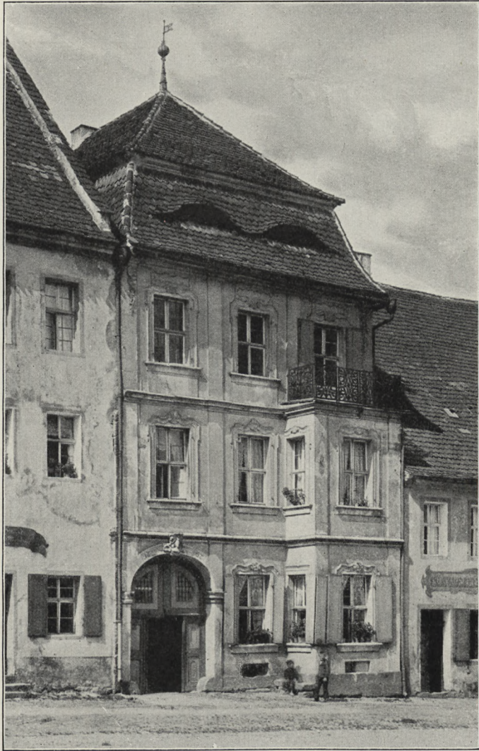
Fig. 15. Auerbach. Wohnhaus von 1757.
