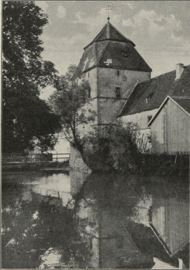
Fig. 49. Michelfeld. Der innere Torturm von Südwesten gesehen.
