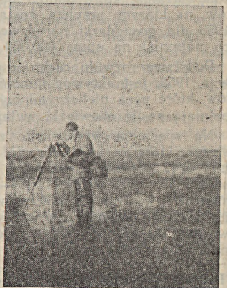
Niwelator chodzi za mną jak pijany. Jak tupnąć, to nitka skacze po lacie. A ciąg ma się zamknąć w milimetrach, bo teren płaski.
