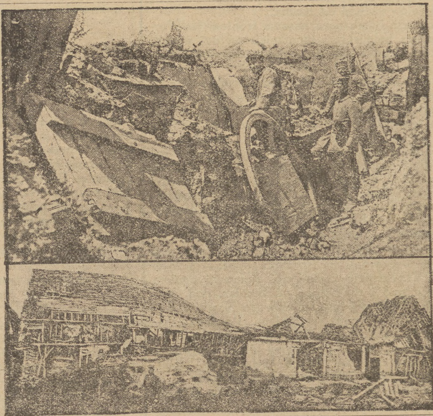
Obrazek nasz pokazuje nam spustoszenia z powodu upartych walk nad Sommą. U góry widzimy betonowane rowy strzeleckie wojsk niemieckich pod Peronne, u dołu zaś pewną liczbę domów mieszkalnych, świadczących o działalności artyleryjskiej.
