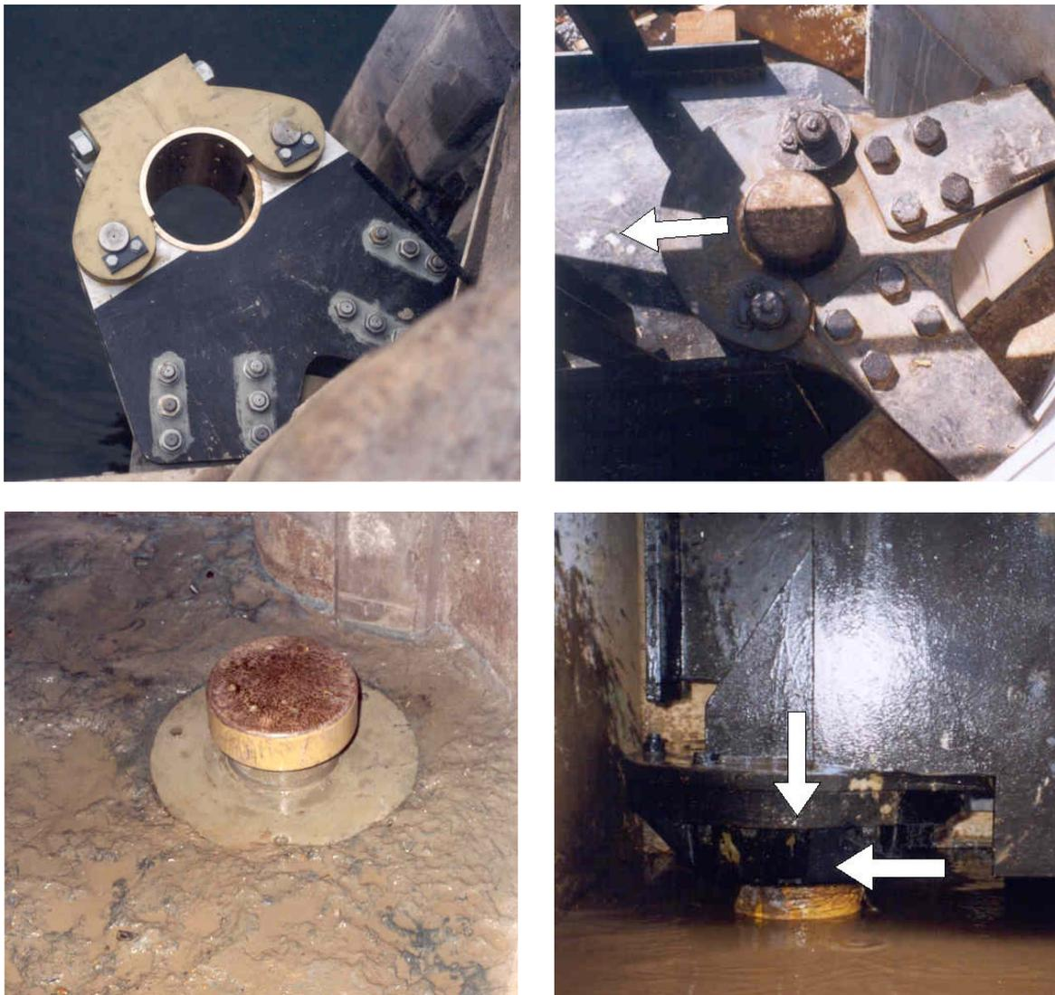
**Fig. 45.** Mitre gate top and bottom hinges in:
