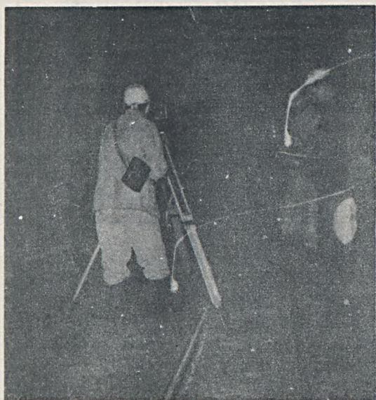
Rys.12. Pomiar kątów teodolitem stojącym w kopalni
