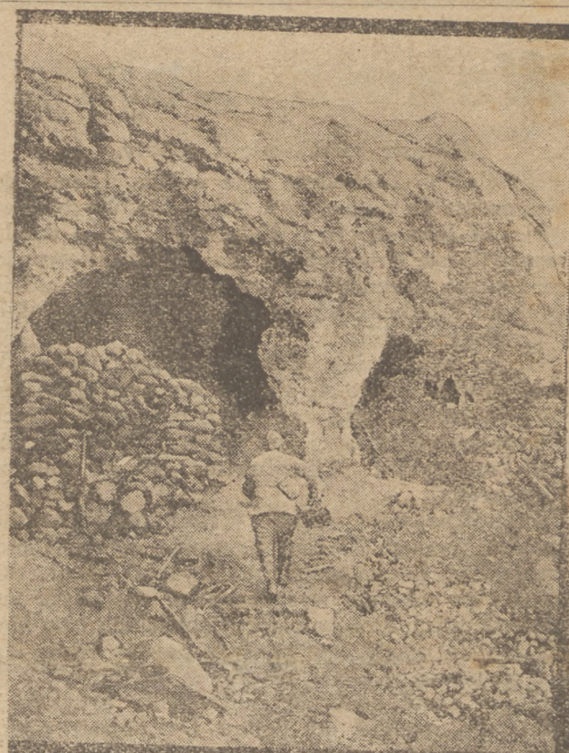
Stanowiska wojskowe zniszczone przez ogień działowy przeciwnika.
