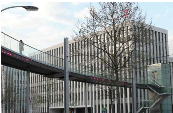
Il. 6.36 Kładka piesza TELECOM, Bonn. (źródło: własne)
