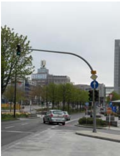
Il. 6.40 U-Tower , Dortmund – widok od strony dworca. (źródło: własne)
