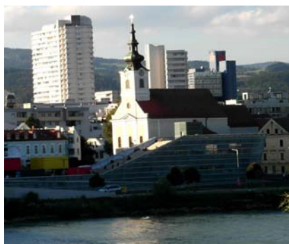
Il. 7.4 Schody na dachu Ars Electronica Center , Liznu. (źródło: własne)
