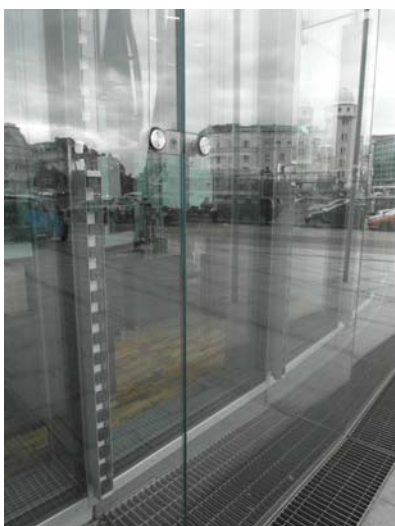
Il. 4.7 System MIPIX firmy Barco zastosowany w UNIQUA Tower w Wiedniu. (źródło: własne)
