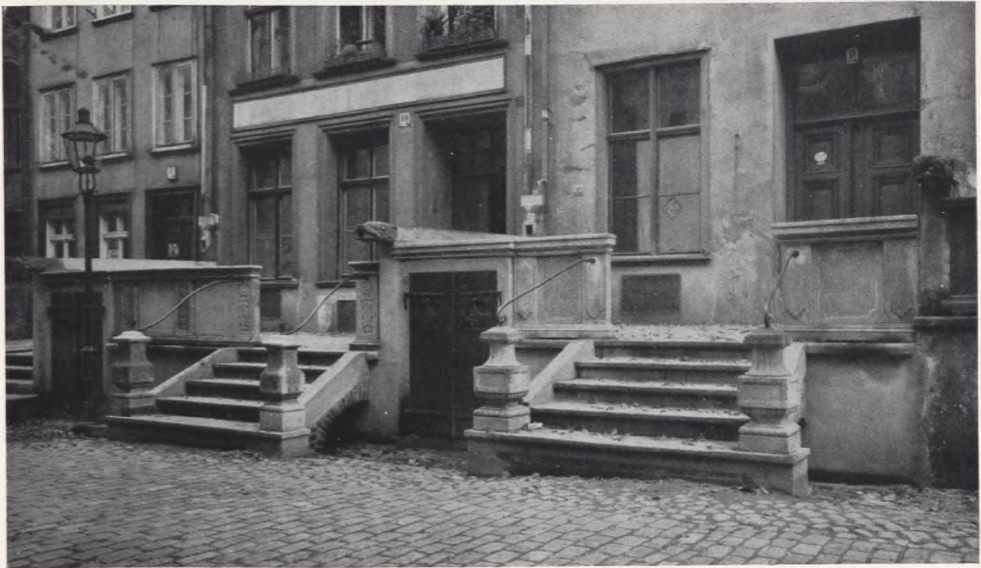
und nach dem Einbau der Beifläge.
