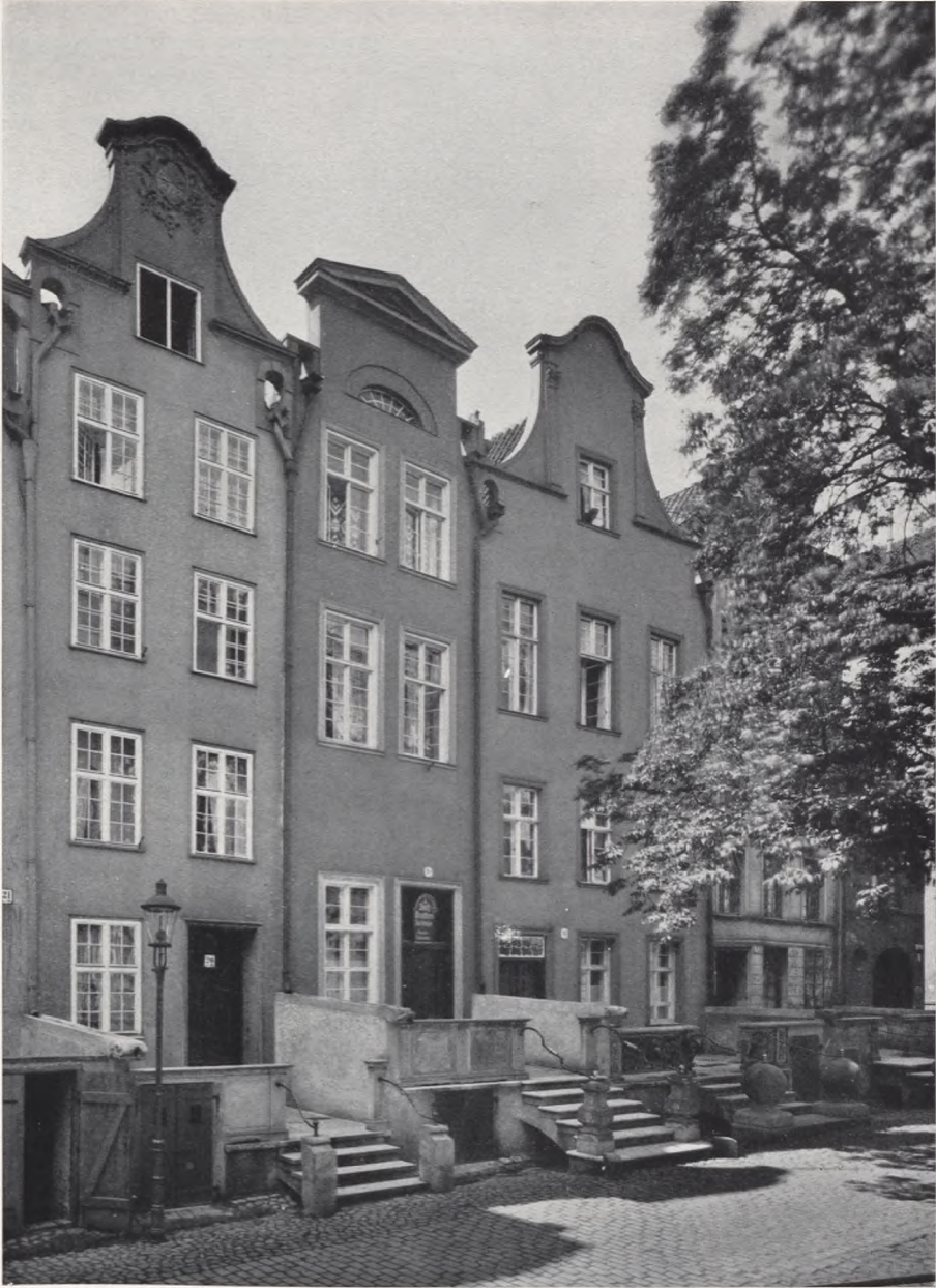
und nach dem Umbau.
