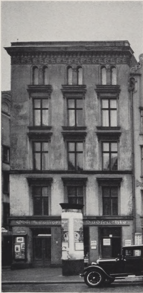
Langer Markt 23, alter Zustand
