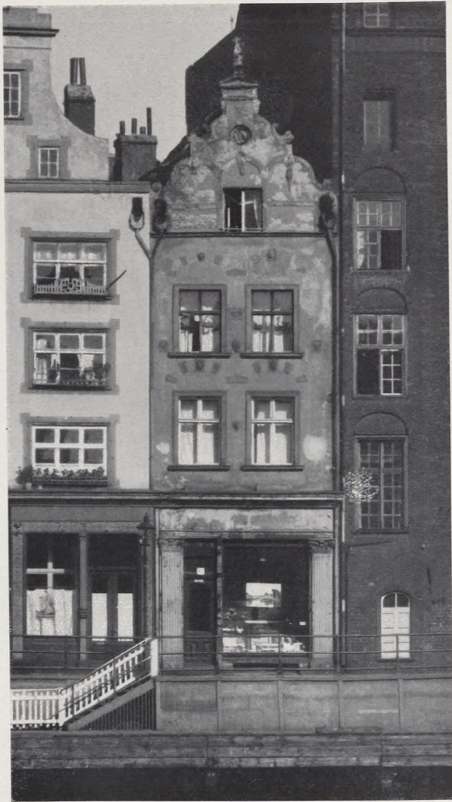
Lange Brücke 13 vor -
