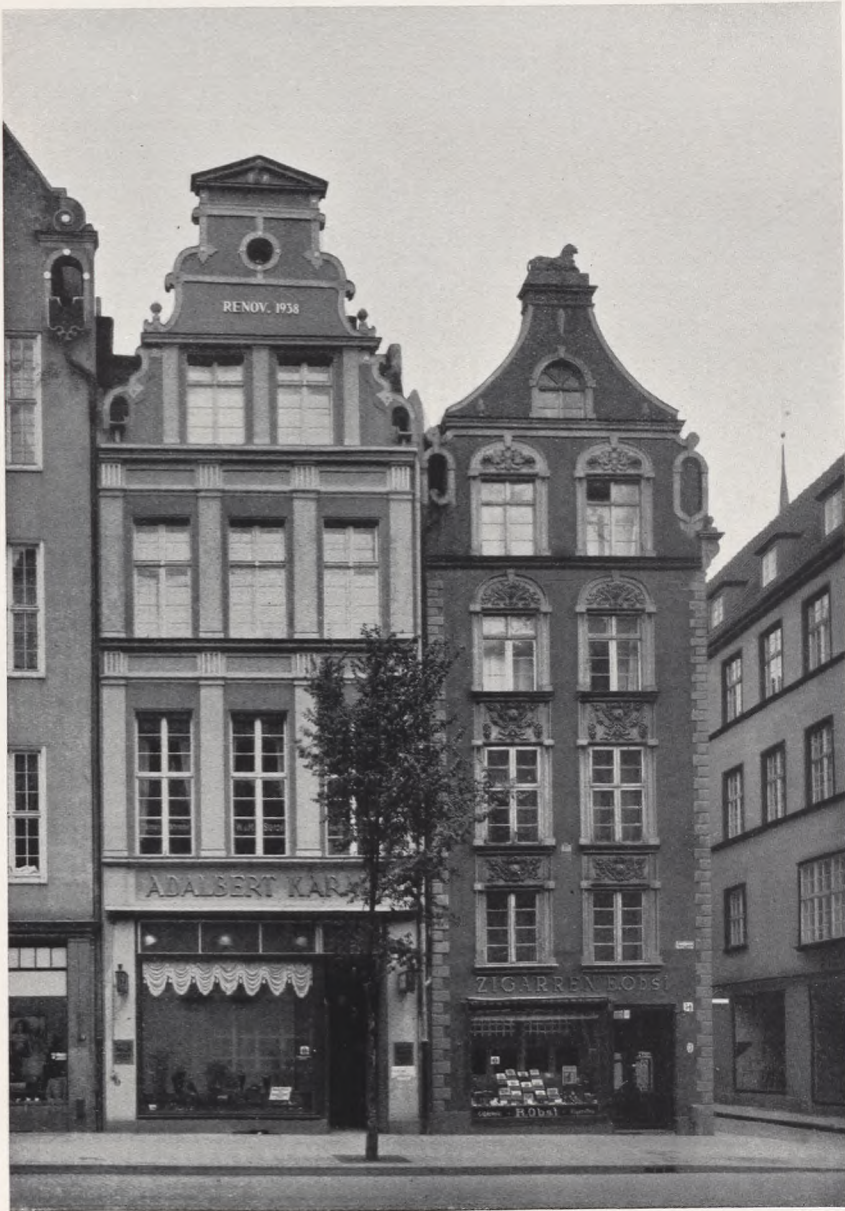
und nach dem Umbau.
