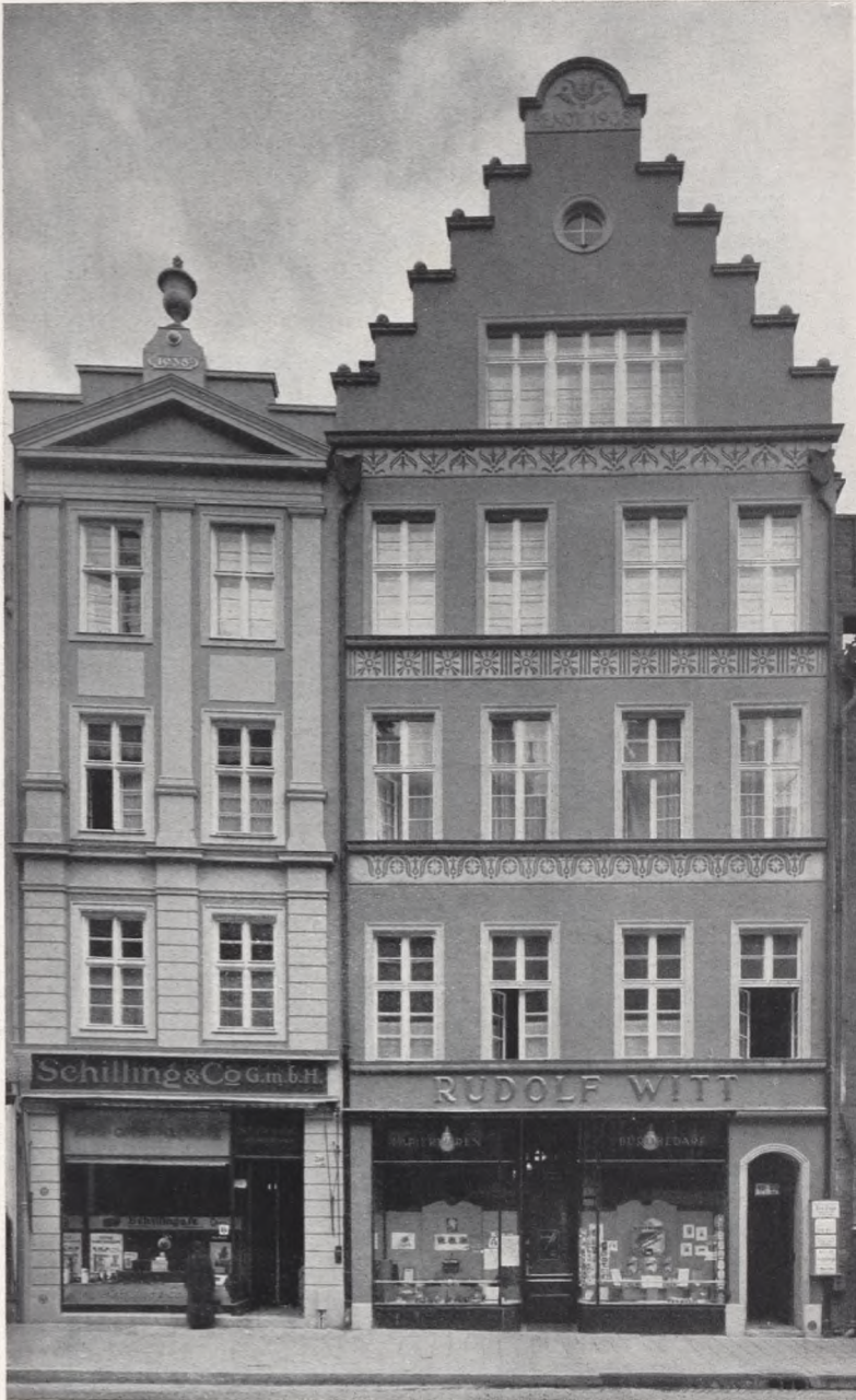
und nach dem Umbau.
