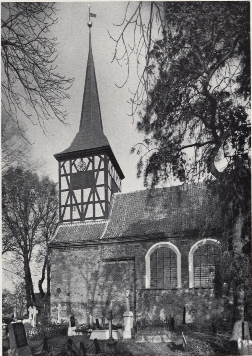
Turm der ev. Kirche in Woslaff nach der Wiederherstellung.
