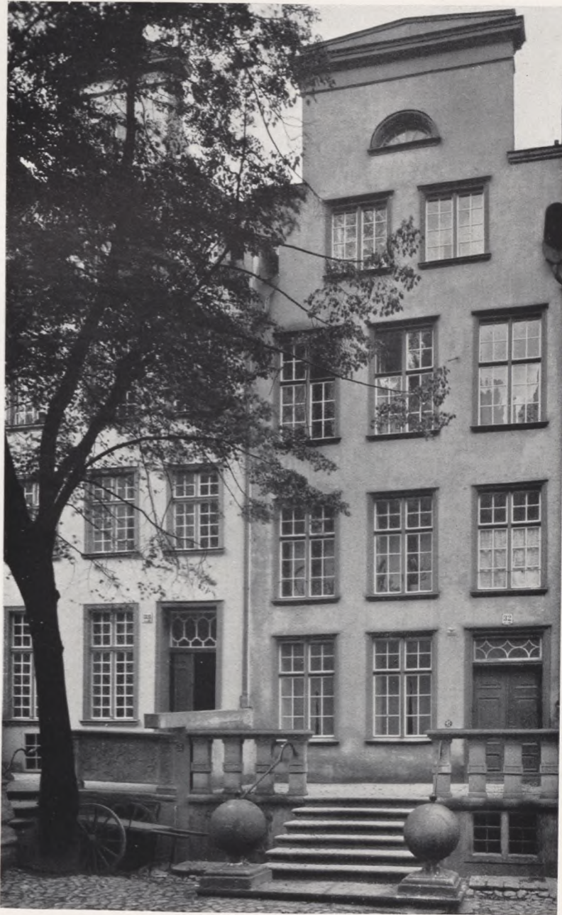
und nach dem Umbau.
