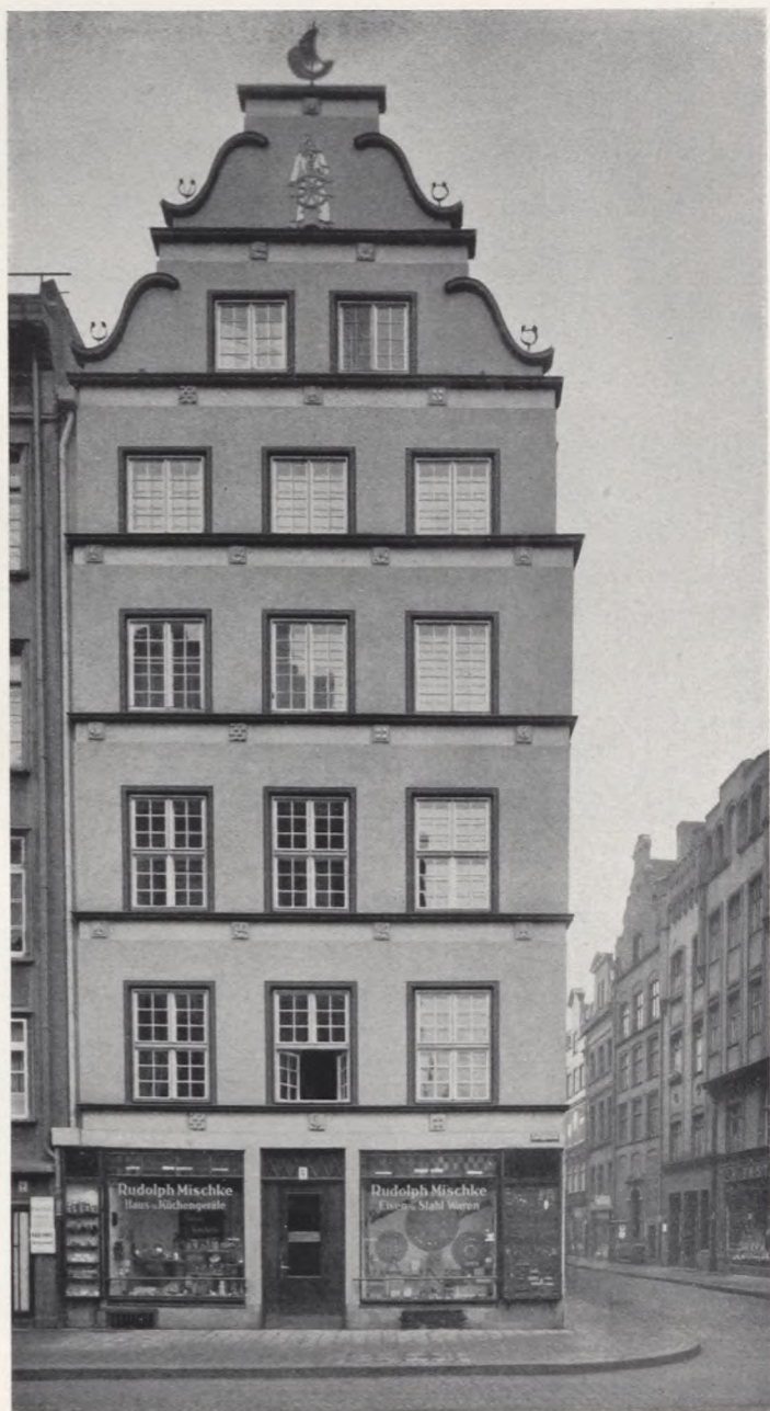
und nach dem Umbau.
