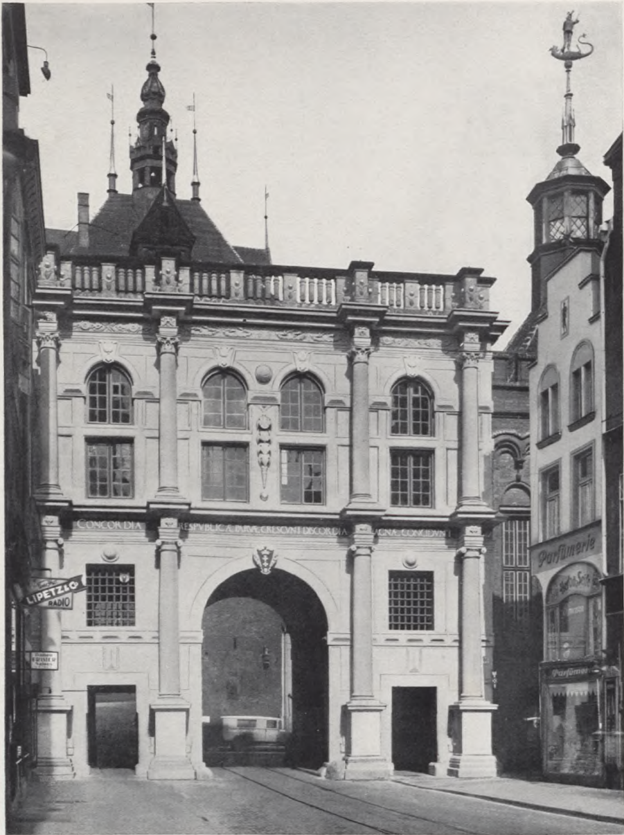
Langgasser Tor, Ostseite, erbaut 1612 - nach der Wiederherstellung.
