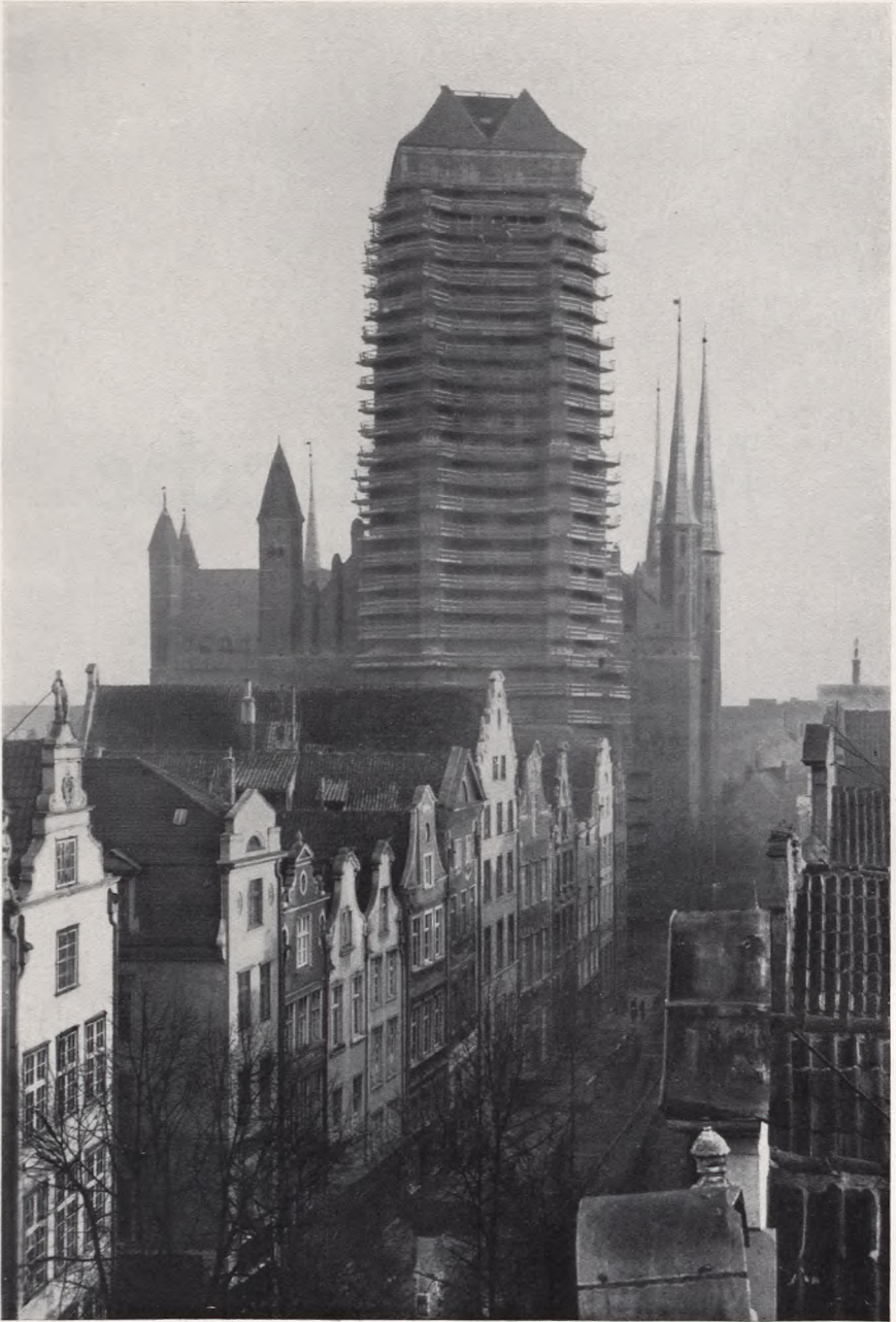
St.=Marien=Kirche, ingerüsteter Turm.
