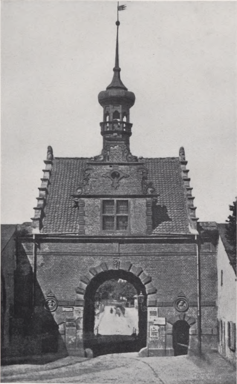
Das ehemalige Jakobstor (1629).
