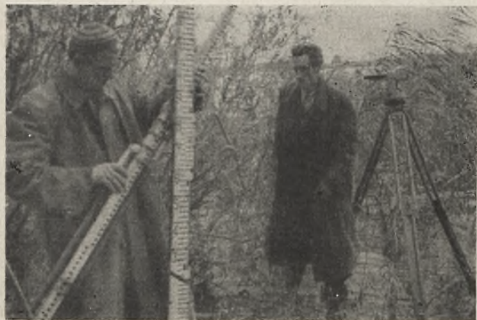
Rys. 4. Starszy pomiarowy montuje łąty. Obok drugi pomiarowy zakłada instrument na statyw.
