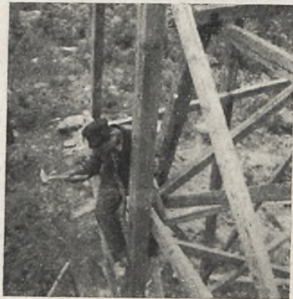
Rys. 3. Montaż wieży triangulacyjnej
