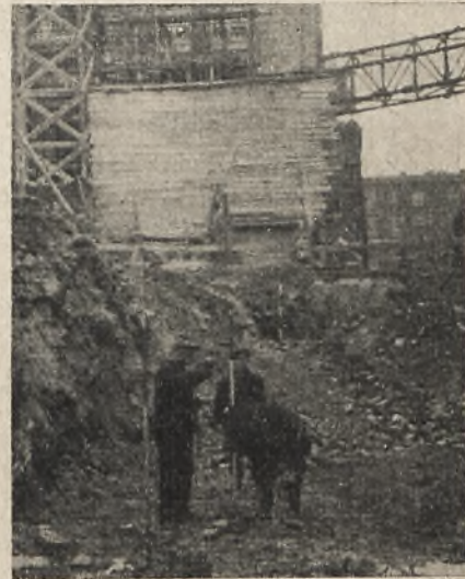
Rys. 7. Wyznaczenie rzędnych fundamentów budynków
