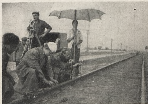
Rys. 10. Prace geodezyjne na szlaku kolejowym
