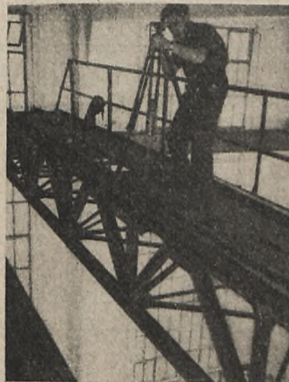
Rys. 8. Regulacja suwnicy
