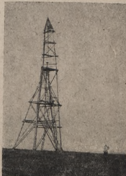
Rys. 9. Uszkodzona wieża triangulacyjna
