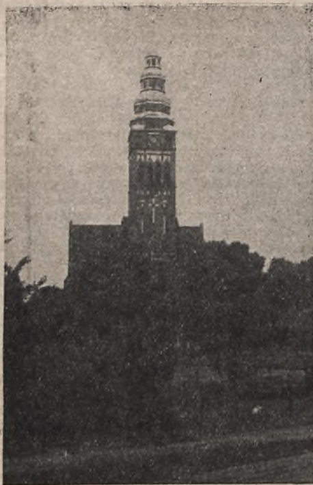
Rys. 1. Wieża kościelna wykorzystana jako znak triangulacyjny
