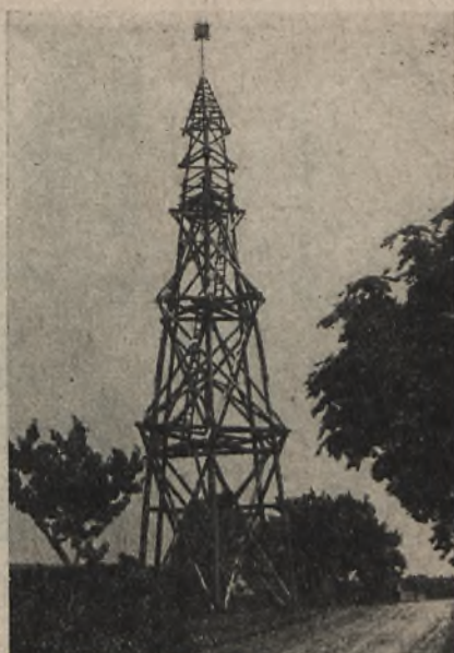
Rys. 12. Niewłaściwe usytuowanie wieży triangulacyjnej na skraju drogi.
