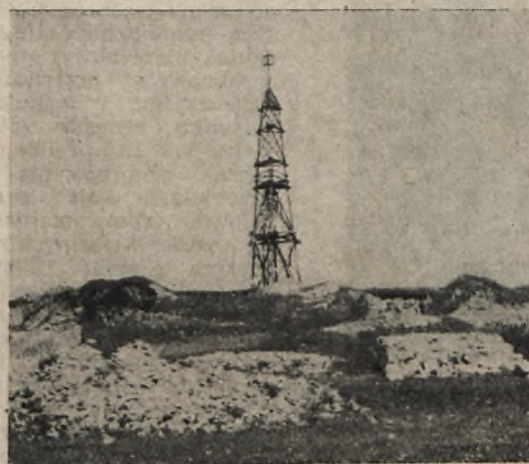
Rys. 11. Niewłaściwe usytuowanie wieży w pobliżu czynnej zwirowni.
