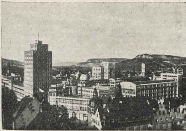
Rys. 1. Ogólny widok zakładów Zeissa w Jenie
