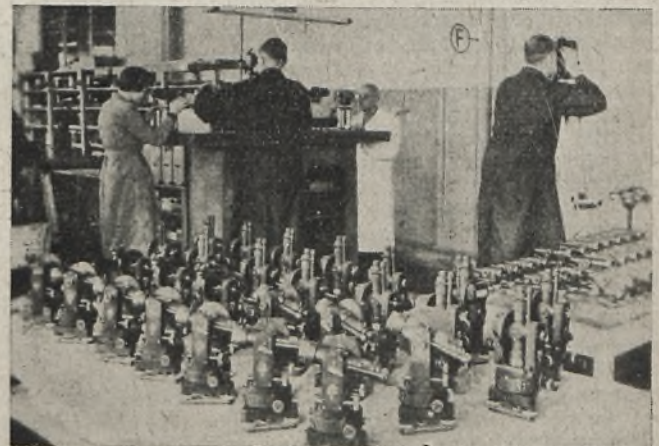
Rys. 3. Zakłady Zeissa: Dział kontroli technicznej
