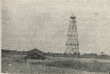
Rys. 2. Pawilon obserwacyjny na tle wieży triangulacyjnej
