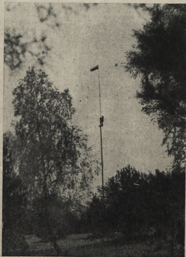
Rys. 1. Ustalanie wywiadem punktów triangulacyjnych w terenie. Na słupie wywiadowczym z wysokości 18 m inżynier bada przebieg celowych na punkty sąsiednie
