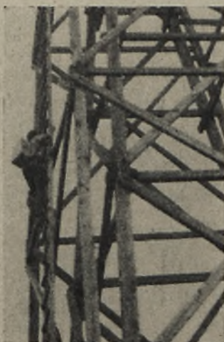
Rys. 3. Wchodzenie na wieżę triangulacyjną. Prawidłowe zabezpieczające przed wypadkiem spowodowanym ewentualnym oderwaniem szczebla drabiny
