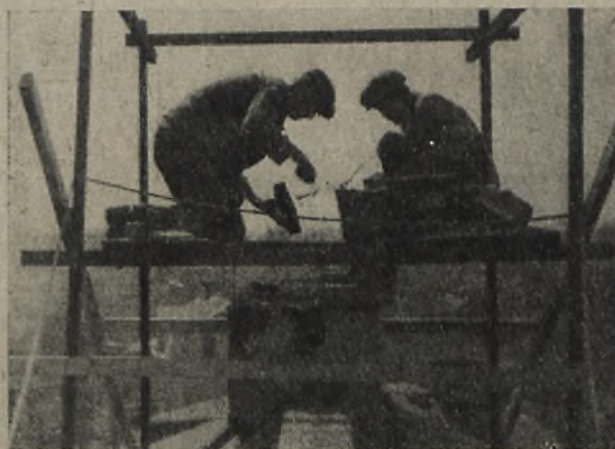
Rys. 4. Rusztowanie dla budujących komin, lina dla donoszącego materiał
