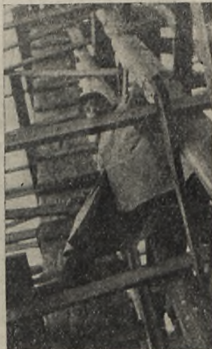
Rys. 6. Widok stanowiska łąty przy pomiarze pionowości filarów betonowych w trakcie budowy (na różnych wysokościach). Pomiarowy chodzi po rusztowaniach bez żadnego zabezpieczenia (około 20 m wysokości).
