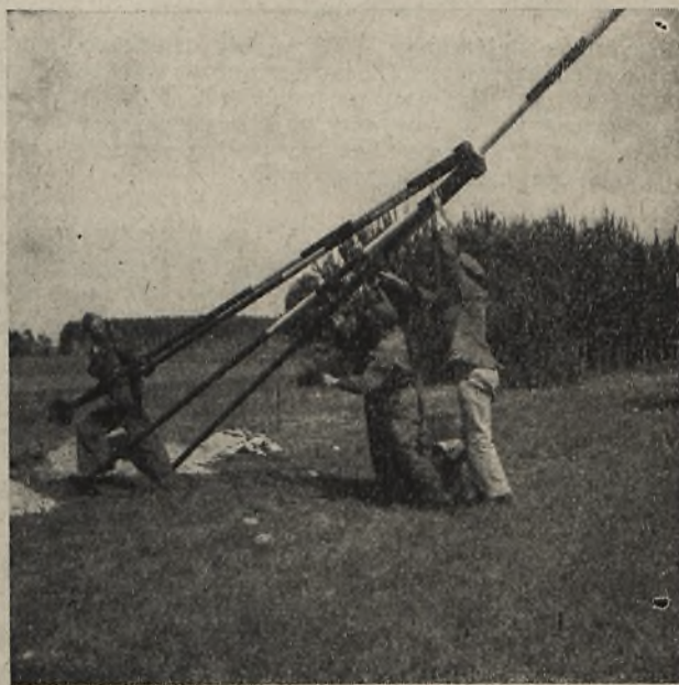
Rys. 7. Na punkcie zagęszczającym ustawiony jest sygnał przenośny metalowy o wysokości 6 m.
