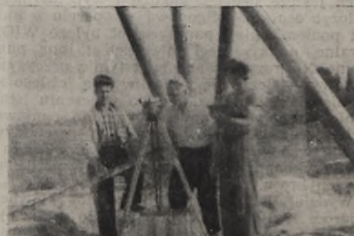
Rys. 12. Niwelacja czopków styków po pomiarze bazy
