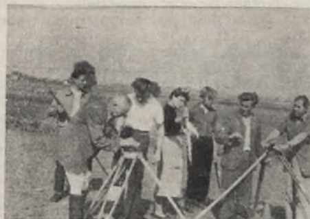
Rys. 7. Przygotowanie drutów do pomiaru bazy. Rys. 8. Rozpoczęcie pomiaru bazy.
