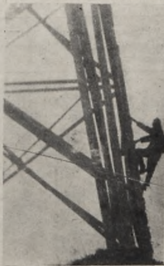
Rys. 5. Wejście na wieżę
