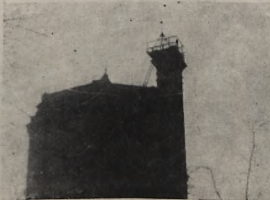
Rys. 1. Budowa znaku triangulacyjnego Rys. 2. Znak triangulacyjny na budowli stałej Rys. 3. Wieża triangulacyjna
