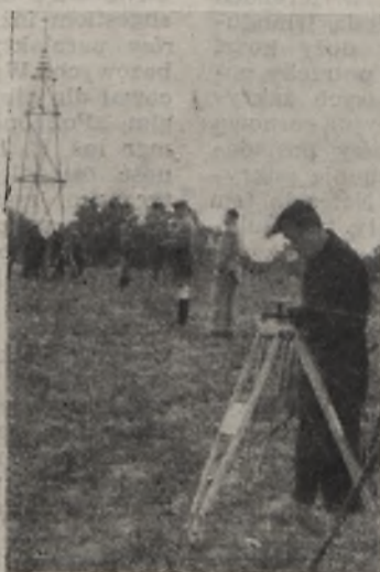
Rys. 12. Niwelacja czopków styków po pomiarze bazy
