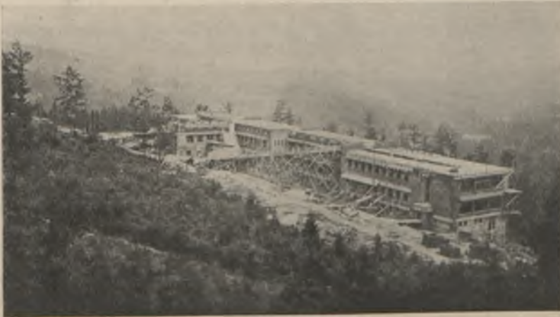
Rys. 235. Uzdrowisko z pawilonem szkolnym w Istebnej (Śląsk Cieszyński). Stan robót w r. 1932.
