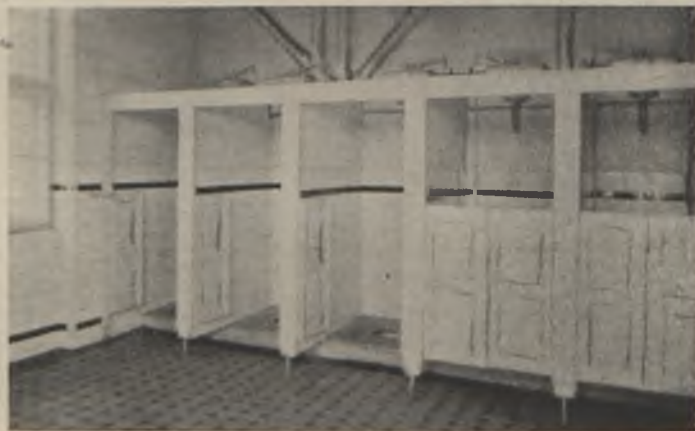
Rys. 104. Urządzenie wewnętrzne ustępu.
