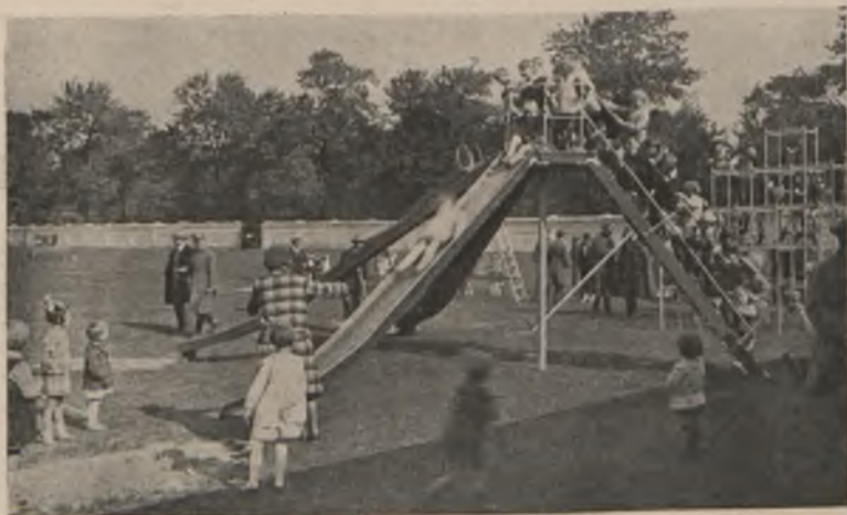
Rys. 336. Ogródek Jordanowski w Warszawie przy ul. Bagatela. Zjeżdżalnia.
