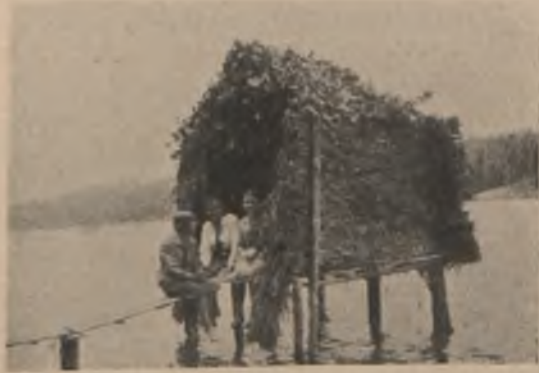
Rys. 370. Domek na palach, zbudowany przez harcerki nad jeziorem Kiełpińskim pod Lidzbarkiem (Zlot w 1930 r.).
