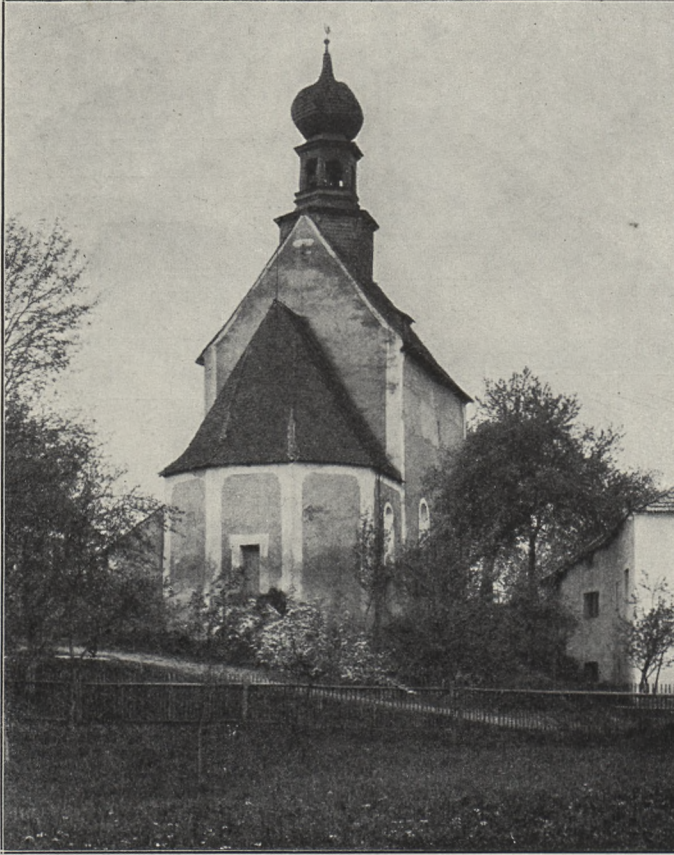
Fig. 71. Obertrübenbach. Ostansicht der Kirche.
