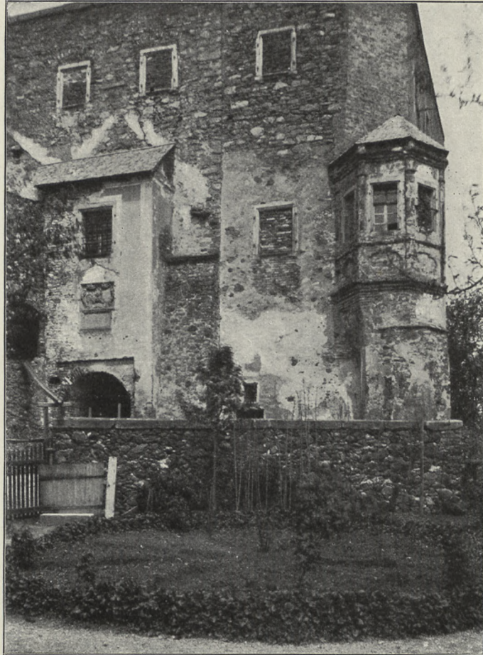
Fig. 15. Falkenstein. Blick auf den Eingang zum inneren Schloßhof u. auf den Erker.
