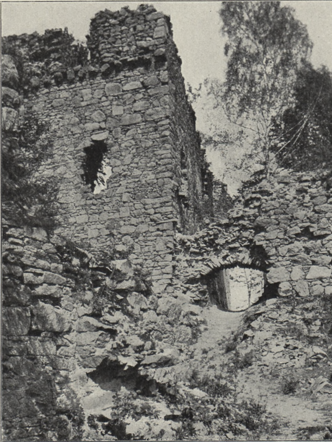
Fig. 51. Kürnberg. Vom Wohnbau der Burg.
