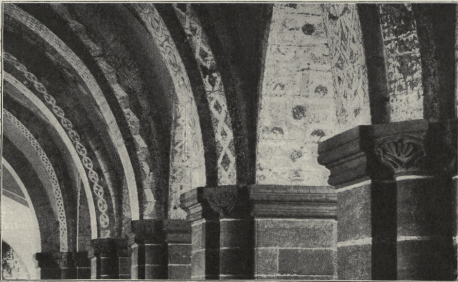
Fig. 185. Walderbach. Gewölbedetail der Klosterkirche.
