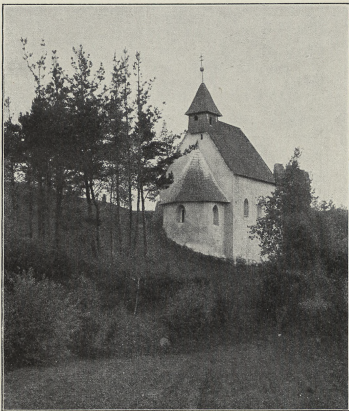
Fig. 131. Siegenstein. Ostansicht der Burgkapelle.
