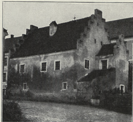
Fig. 107. Reichenbach. Wohnhaus südlich am Kloster.
