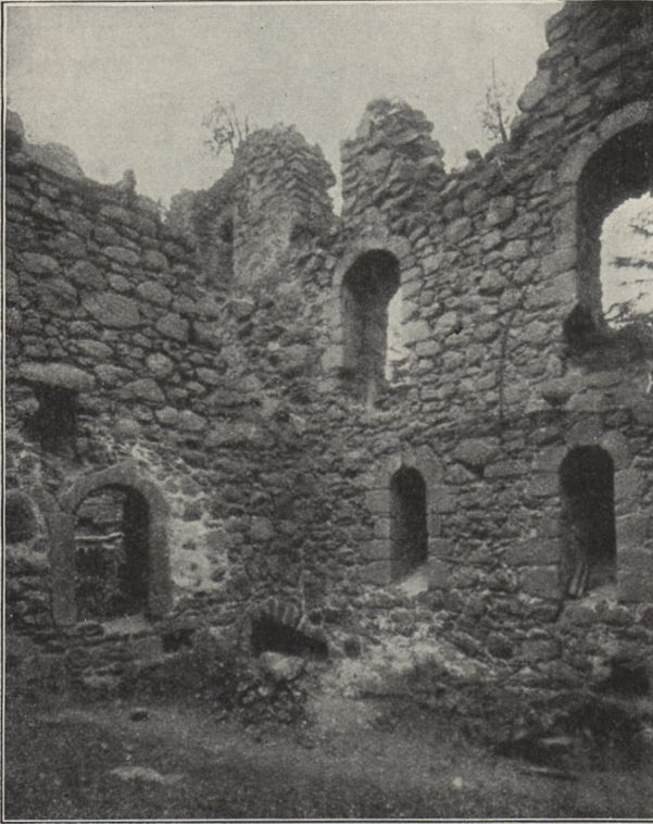
Fig. 151. Stockenfels. Inneres des Südbaus, nördliche Hälfte, Südwestecke.
