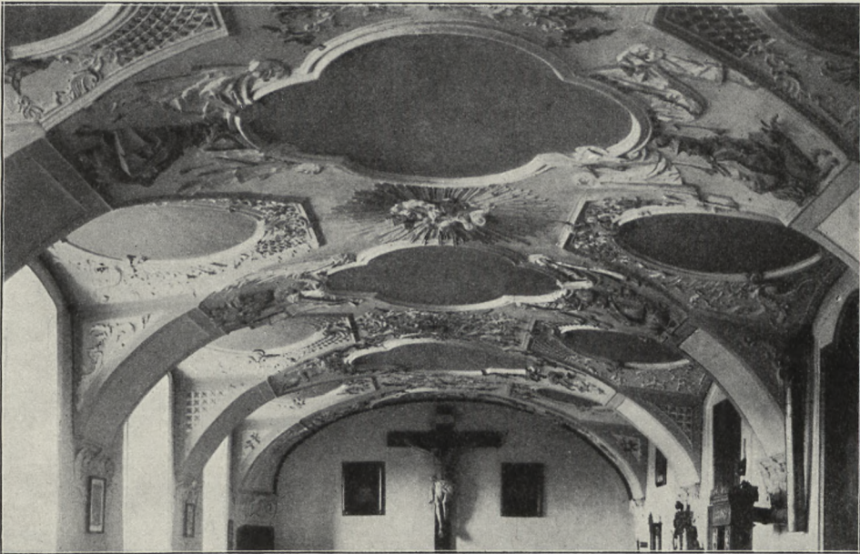
Fig. 106. Reichenbach. Stuckdekoration des Refektoriums im Kloster. Aufgenommen 1897 vor dem Brande.
