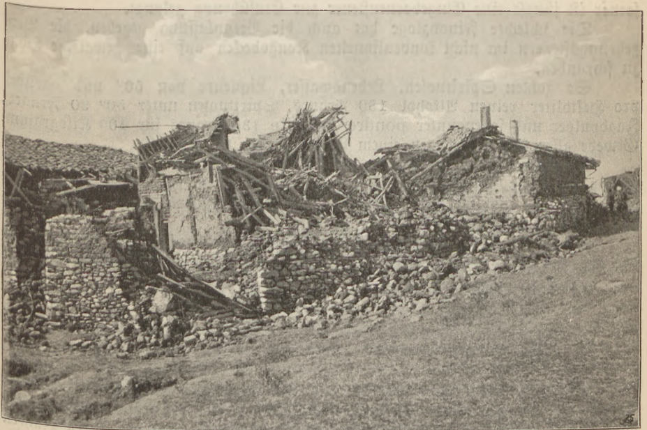
Straße in Güvesne nach dem Erdbeben vom 5. Juli 1902. (Zu S. 19.)
