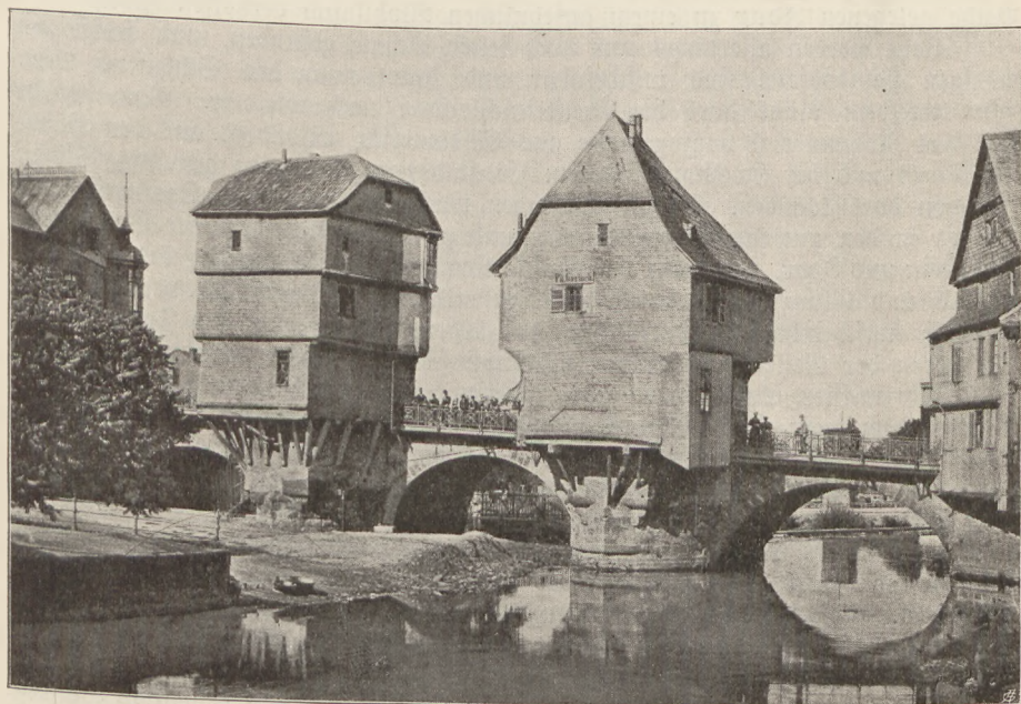
Mäbebrücke in Kreuznach. (Nach einer photographischen Aufnahme.)
