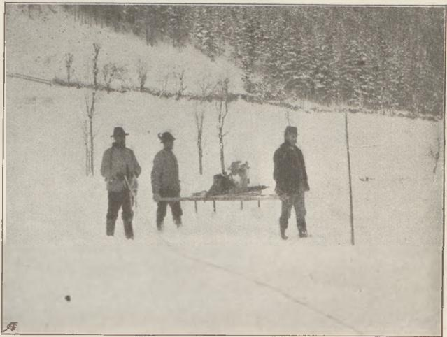
Lotungsarbeiten am Untersee. Transport der Lotmaschine.
