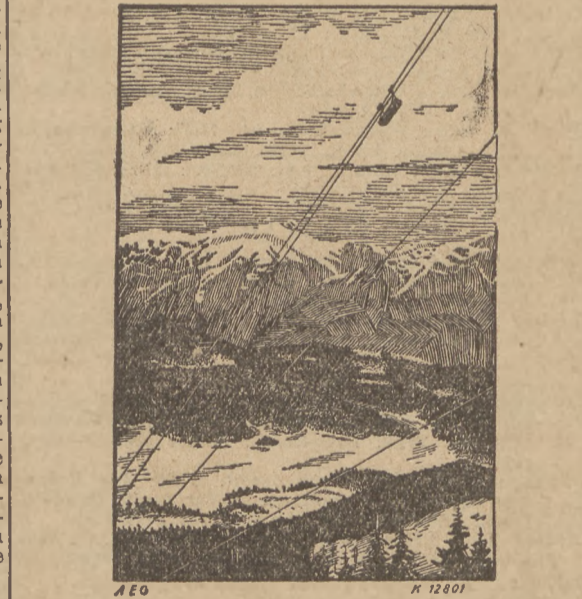
Bild 2a: Seilseilbahnen zu den Fenstern.
