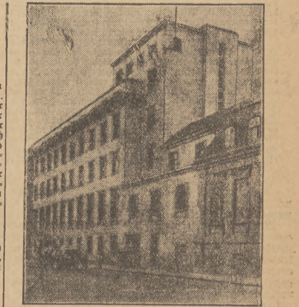
Der Neubau der Reichskanzlei in Berlin wurde am 18. Dezember nach zweifähriger Bauzeit feierlich seiner Bestimmung übergeben.
