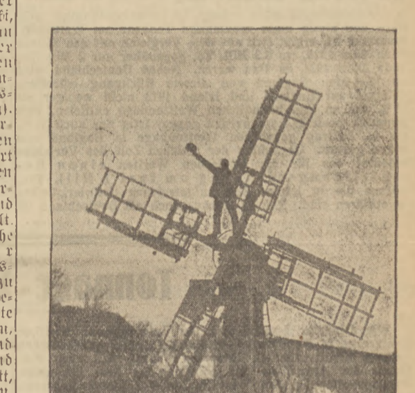
Diese selbstgebaute Mühle steht in Gollmann, der Stellmacher August Landmann hat sie sich vor 15 Jahren zum Antrieb für eine Bandsäge gebaut.
