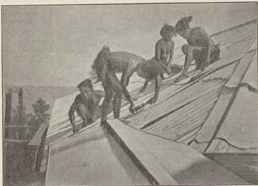
Eingeborene an einem Wellblechdache arbeitend.
