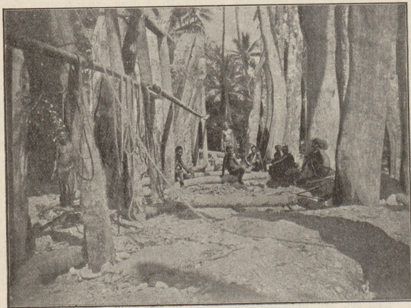
Bau eines großen Gemeindehauses, das Aufrichten der großen Stützpfiler aus Riesenbaumstämmen. Augenblicklich „Pause“.
