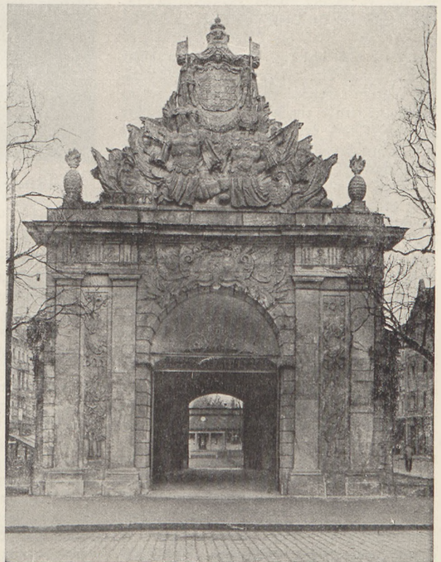
Nach der Instandsetzung
