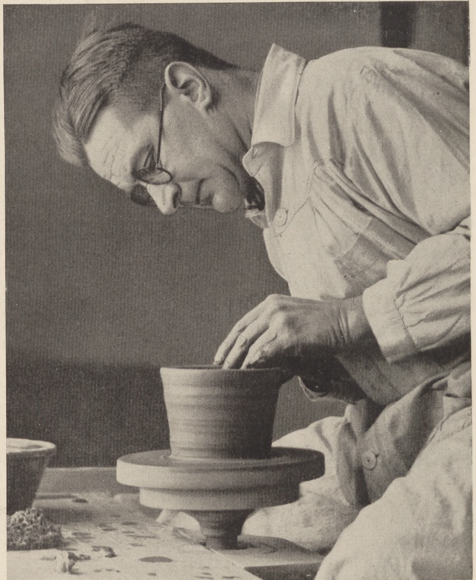
Unter beständigem Drehen wird der Ton hochgezogen
