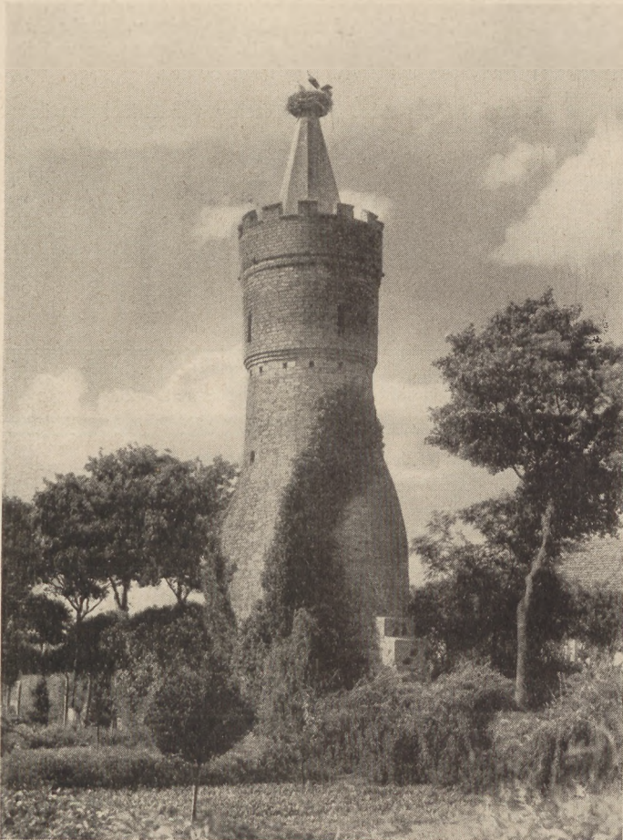
Der alte „Kiel in de Mark“
