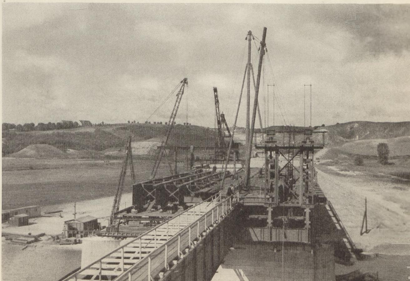
Vom Bau der Westoderbrücke: Gesamtlänge rd. 244 Meter, Mittelöffnung 34 Meter, zwei Seitenöffnungen von je 60 Meter, Höhe des Stahlüberbaues über dem Wasserspiegel rund 12 Meter
