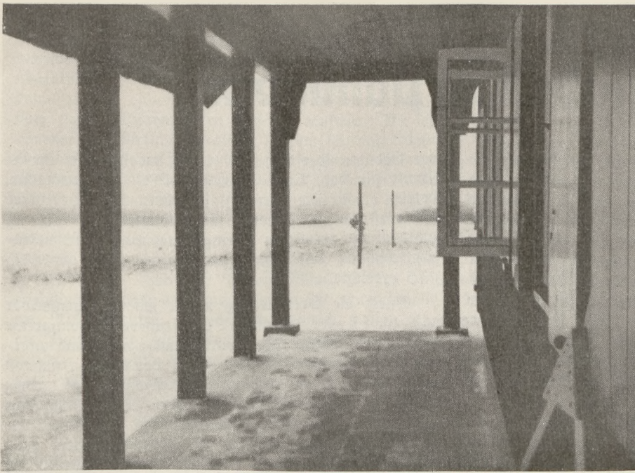
Blick durch den überdachten Gang
