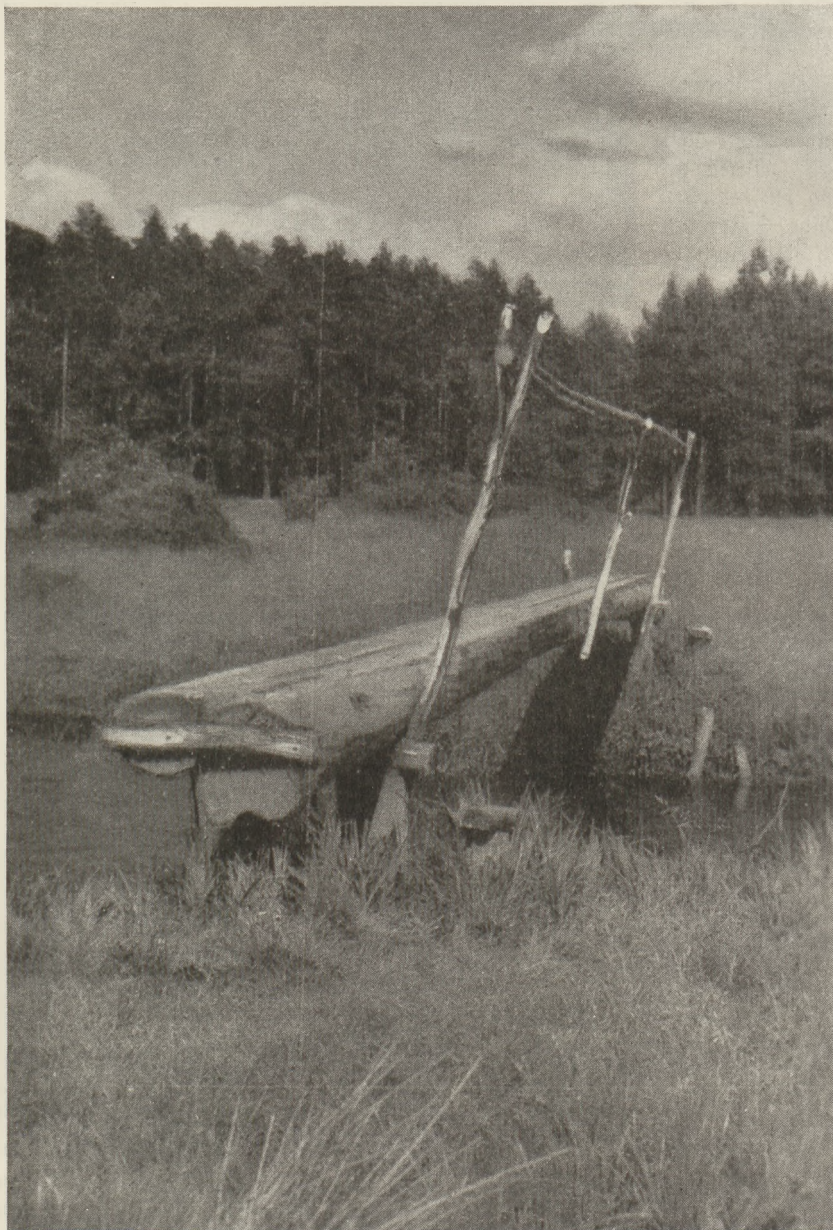
Zwischen vier starken Pfählen ist eine lange, dicke Eichenbohle befestigt.
