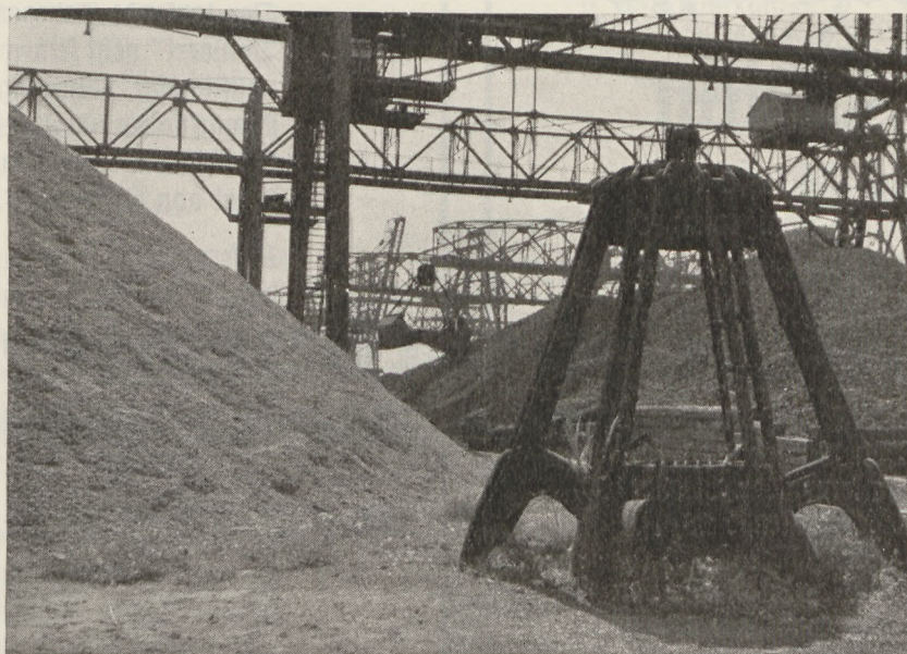
Reiherwerderhafen Lagerplätze für Massengut
