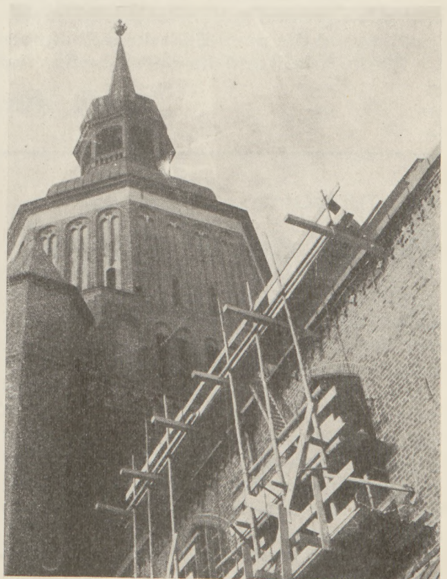
Instandsetzung der Marienkirche Stralsund
