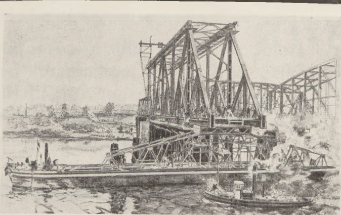
Einschwimmen des großen Stromüberbaues der Eisenbahnbrücke über die Oder bei Zäckerick
