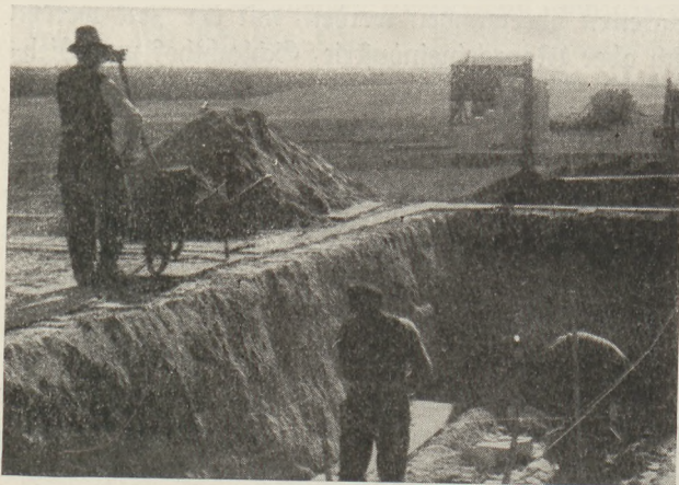
Siedler in der Baugrube
