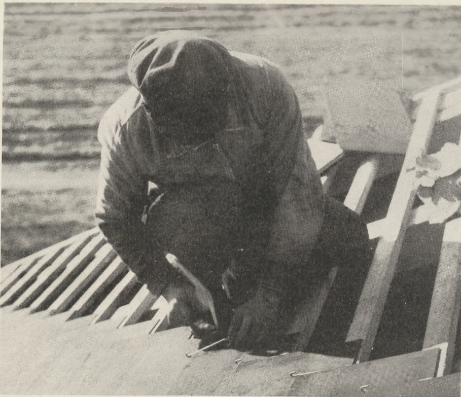
Ein Siedler beim Dachdecken
