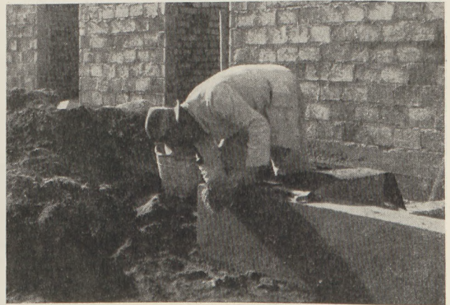
Bearbeitung des Betonfundamentes
