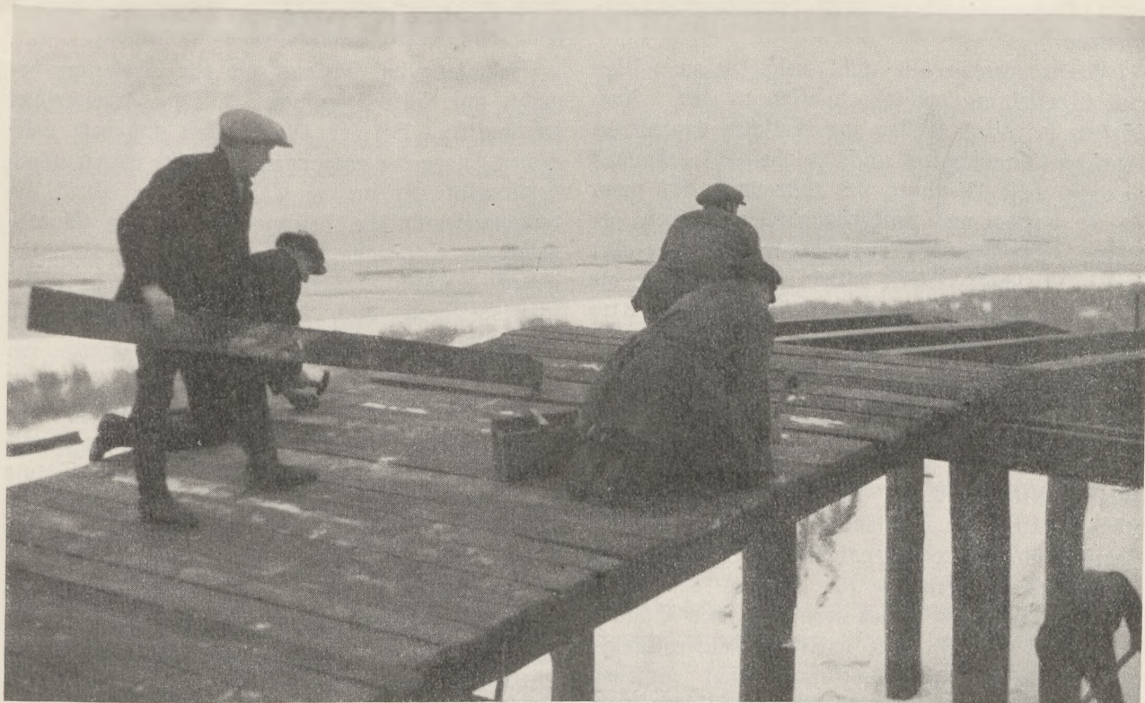
Die Seebrücke wird für den Sommer erneuert
