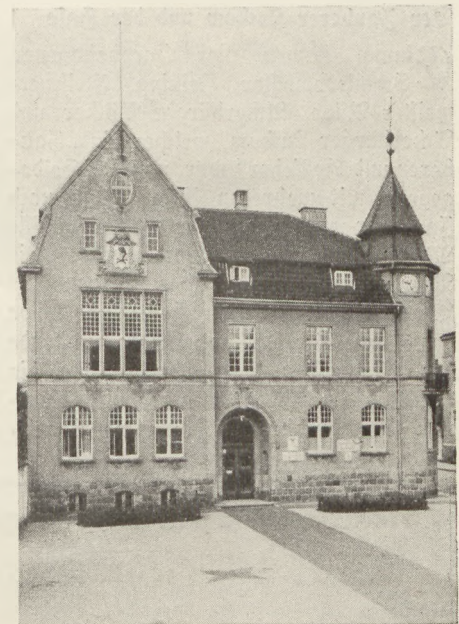
Das Rathaus, erbaut 1912
