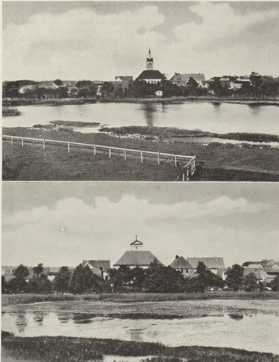
Blick über den Mühlenteich auf Jacobshagen. Oben: die Kirche mit dem alten Turm. Unten: starke Verlandung des Teiches
