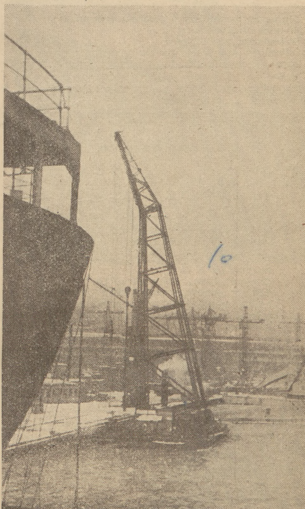
100-tonowy dźwиг pływający, który oddał wielkie usługi przy oczyszczeniu i uruchomieniu portów. Na dalszym planie wielka kadłubownia i dźwigi Stoczni Gdańskiej.
