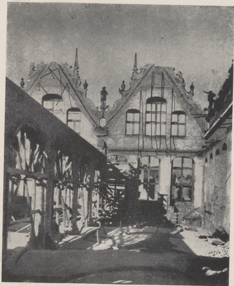
Ryc. 25. Zbrojownia w trakcie odbudowy
