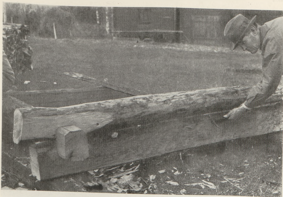
Fig. 22. Stock drages med dragjárn. Orsa socken, Dalarna. Foto förf. och O. Ekberg (E. U. 1929).
