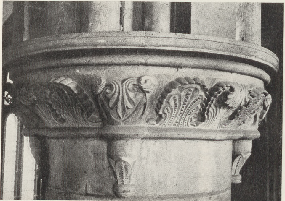
Fig. 8—10. Pelarekapitäl i Linköpings domkyrka. Överst (fig. 8 och 9) knippepelarekapitäl från den trondheimsk-engelska perioden. Underst ett av gotlandsmästarens rundpelarekapitäl. Foto S. Curman.
