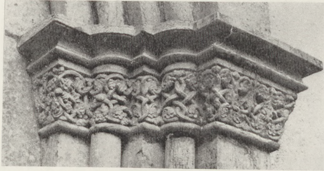
Fig. 46 (överst). Impostlist från fönster i Linköpings domkyrka.
