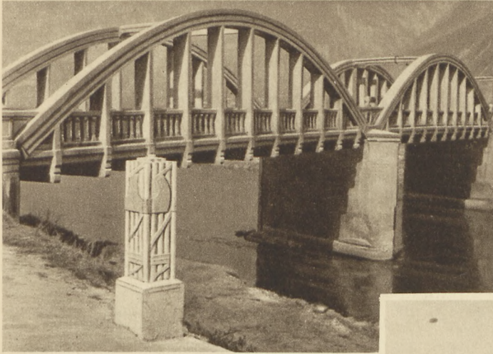
Neue Etsch- brücke bei Salurn mit römischem Lick- renbündel.
