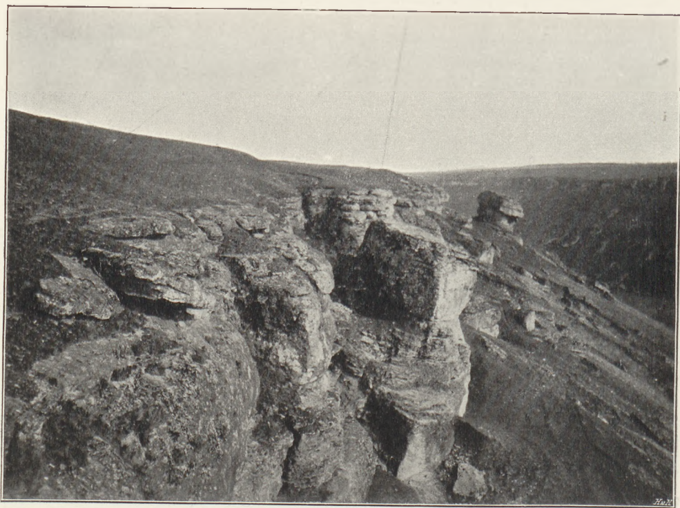
Lewy stok jaru Dupy poniżej Bedrykowiec w Zaleszczykiem. Usuwanie się twardych ławic cenomańskiego piaskowca, spoczywającego na mało zwięzłych, ilastych utworach sylurskich. (Według fotogr. zdjęcia autora.)
