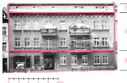
IV.003. fasada trzyczęściowa: de Gaulle 16
