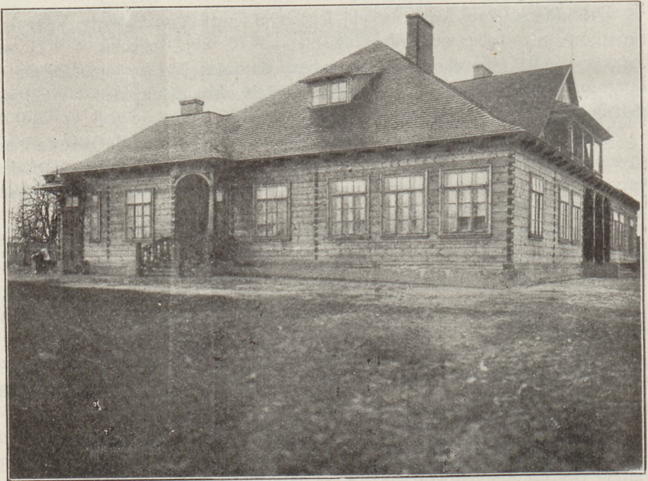
Z wystawy prac samorządu powiatowego. Nowozbudowany dom sejmikowy w Ko- stopolu.
