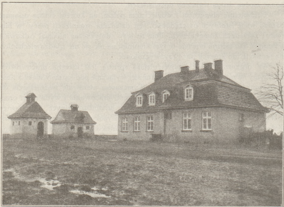
Z wystawy prac samorządu powiatowego. Budowa szkół powszechnych przy udziale samorządu powiatowego. Nowo wybudowany w 1925 r. gmach 2-klasowej szkoły we wsi Longinówce, pow. Piotrkowski.
