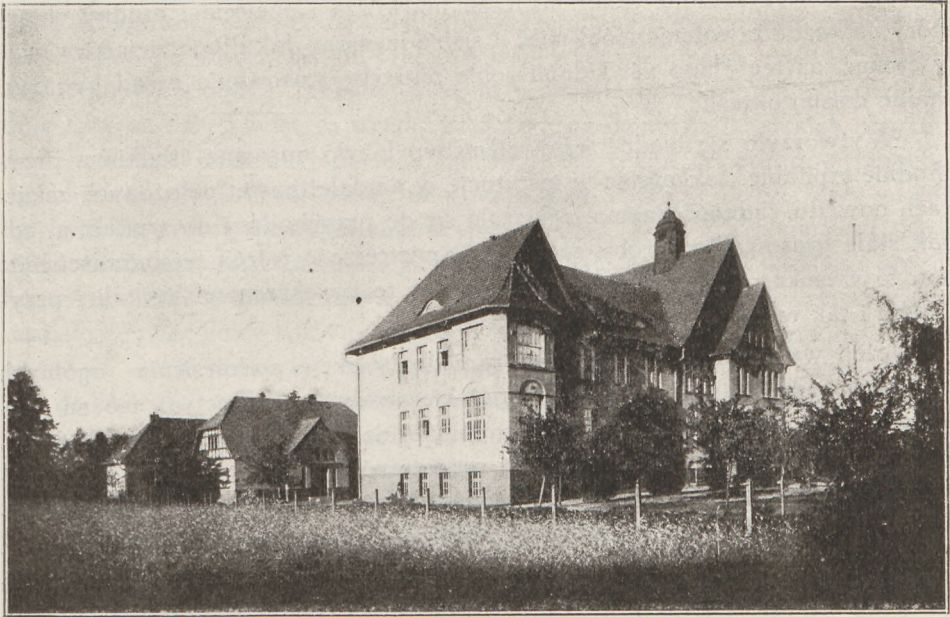
Z wystawy prac samorządu powiatowego. Szpital powiatowy w Nowym Tomyślu.
