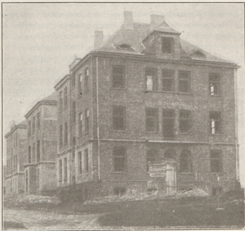
Z wystawy prac samorządu powiatowego. Budujący się gmach szpitala powiatowego w Gostyninie (1925 r.).
