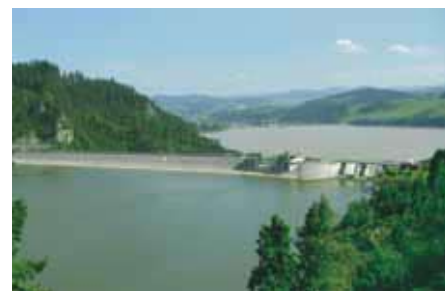
Fot. 1. Zapora wodna Niedzica-Czorsztyn, poniżej zbiornik wyrównawczy Sromowce Wyżne Fot. Archiwum autora
