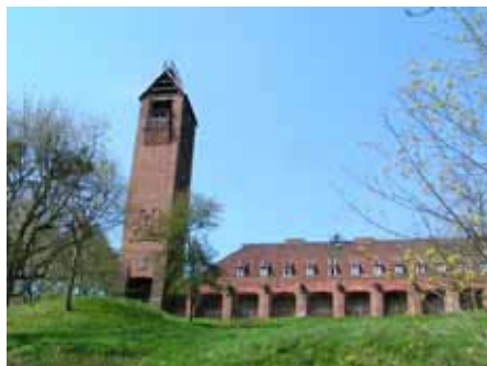
Paul-Beneke-Jugendherberge widok od strony wschodniej, widoczna brama wejściowa u podnóża wieży Fot. A. Perz
