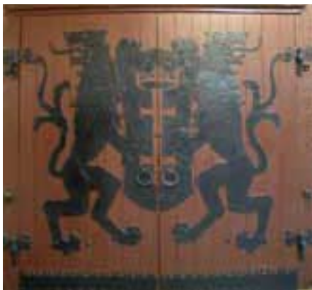
Wykonany z blachy łączonej nitami herb gdańska znajdujący się na drzwiach prowadzących do auli Fot. A. Perz
