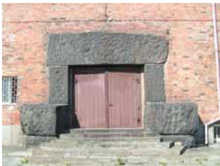
Monumentalny portal główny, zbudowany z ogromnych głazów narzutowych, dominuje nad fasadą Fot. A. Perz
