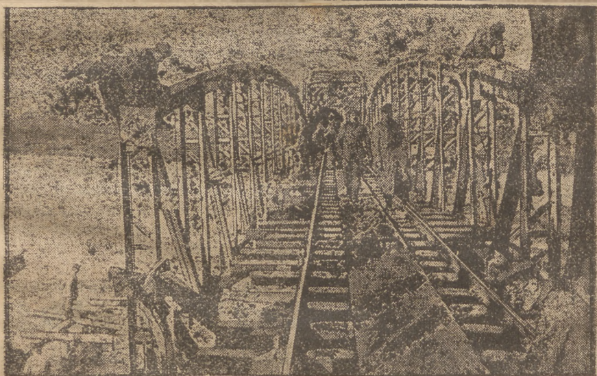
Niemieckie oddziały budowy kolei żelaznej zajęte szybkim odbudowaniem mostu przez Argesul, zniszczonego podczas odwrotu przez nieprzyjaciela.
