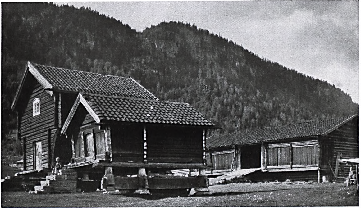
Abb. 386: Stabur und Scheune aus Numedalen. (Aufnahme von Neupert, Oslo.) Der linke, in reinem Blockbau errichtete Speicher ist der jüngste der Bauten. Bemerkenswert ist die farbige Fassung, die das Hirnholz weiß heraushebt.
