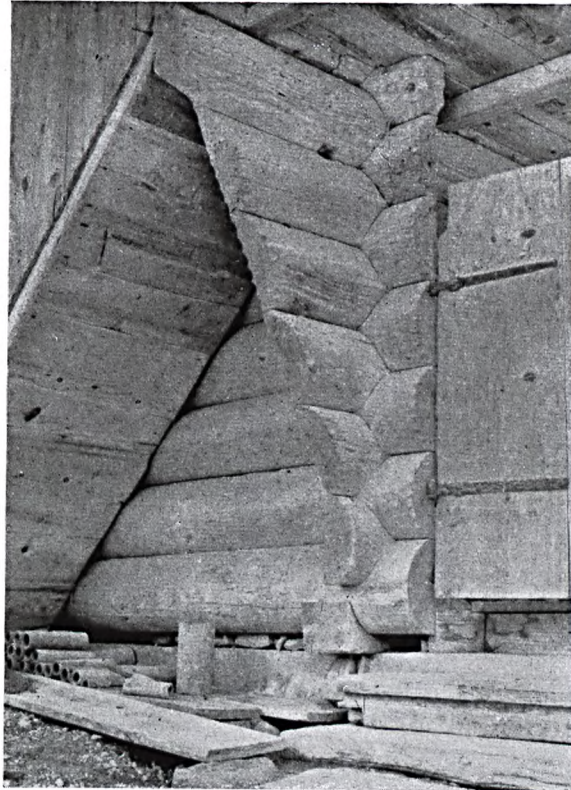
Abb. 357: Ausschnitt von einem Speicher aus Egiswyl, Kanton Bern. Trotzdem die Blockbalken aus einseitig gerundeten Halbhölzern bestehen, wirkt die Konsole geschlossen. Der mit dem Hohlmeißel ausgeführte Kantenschmuck hilft die Bindung der einzelnen Hirnhölzer als Einheit für das Auge zu verdeutlichen.
