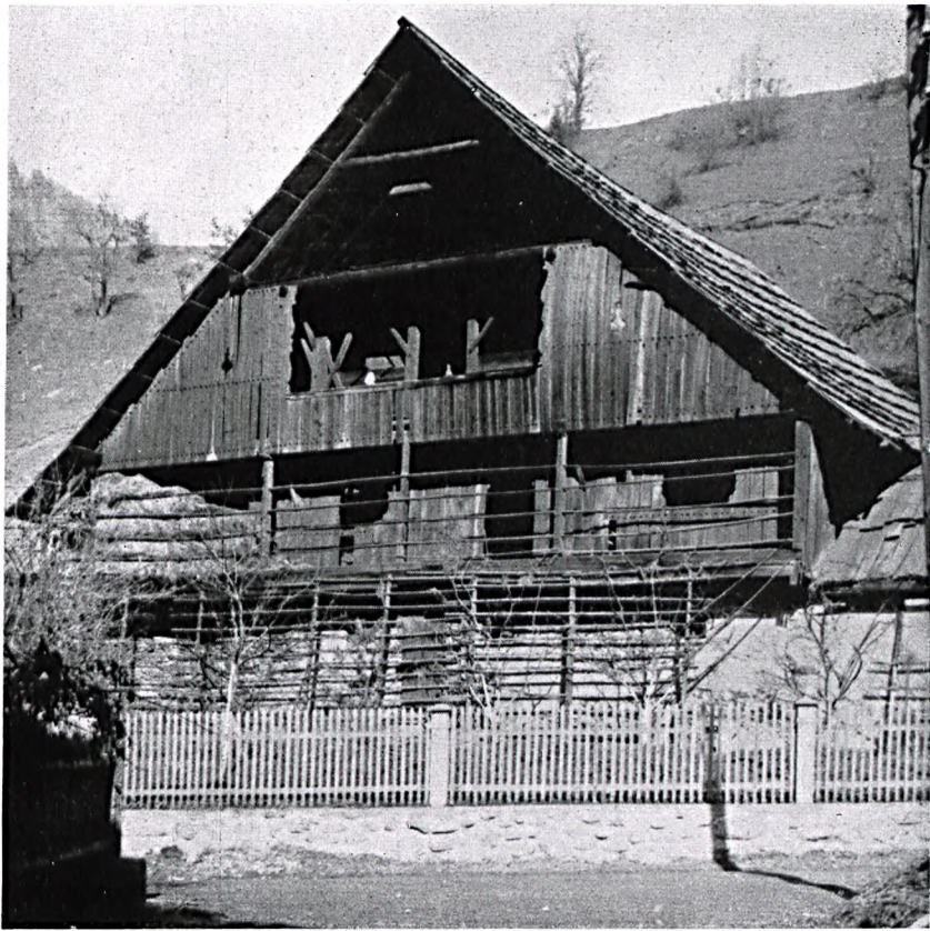
Abb. 343: Tenne aus Radenthein in Kärnten mit Giebelverschalung. Die Schalbretter wurden mit sichtbaren Holznägeln angenagelt, was dem Ganzen einen wirkungsvollen Schmuck verleiht. Nur an dem mit zwei Brettern verkleideten Brustriegel kamen Eisennägeln zur Anwendung.
