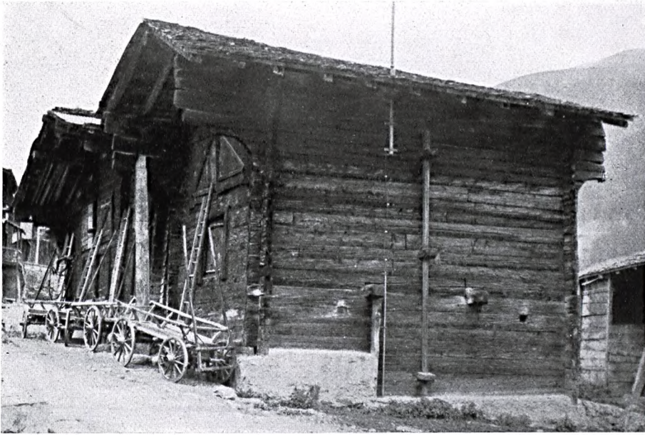
Abb. 410: Mit Zangen gesicherter Speicher ohne Stütze[n] aus Münster im Wallis
