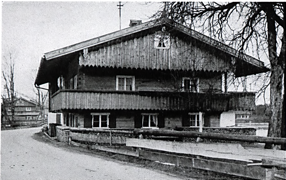
Abb. 345: Bauernhaus aus Wegscheid bei Lengries. Am Giebel sind die Fugen der Verschalung mit Deckleisten überdeckt; ein Gefüge, das sich erst seit dem Aufkommen der Eisennägel entwickelte.
