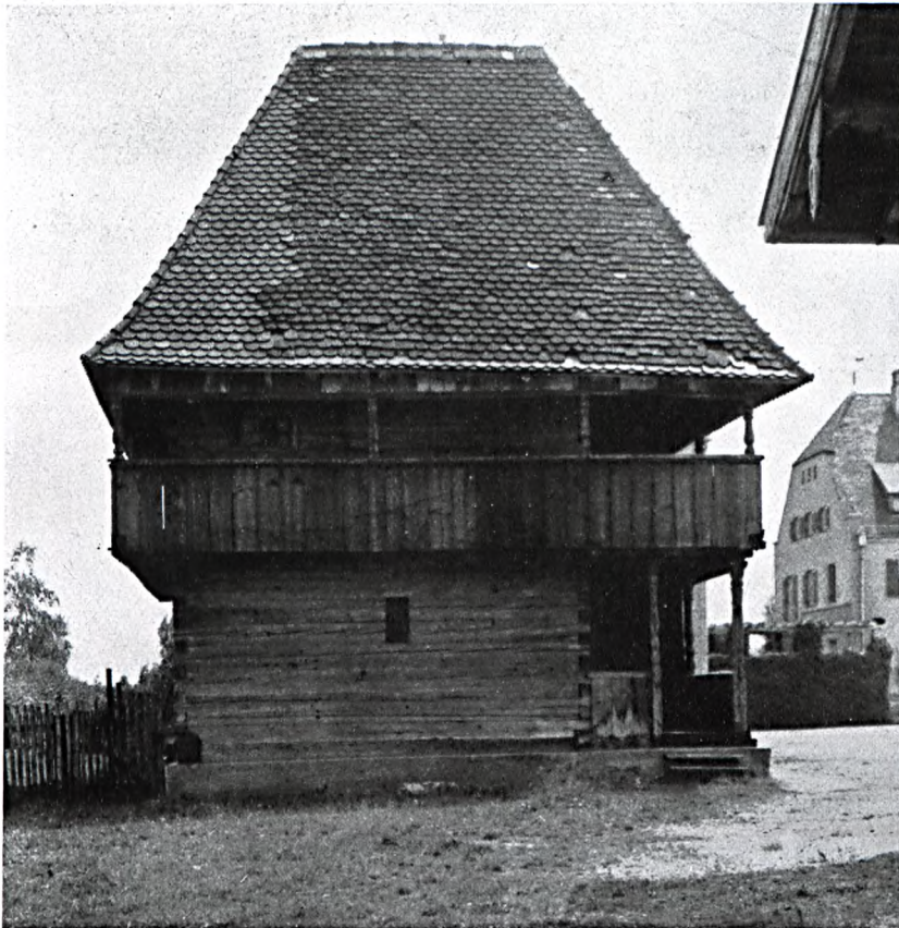
Abb. 391: Seitenansicht des Kastens aus Niederneuching.
