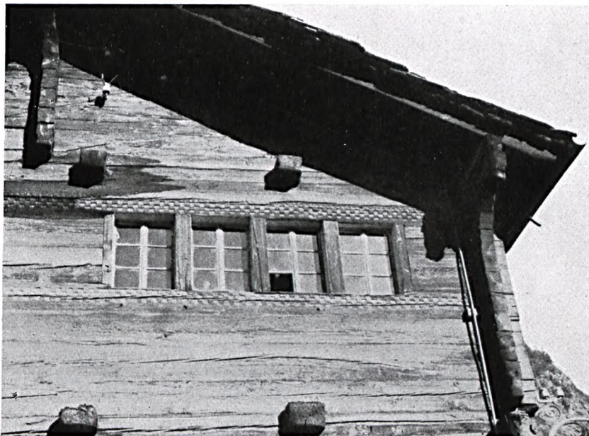
Abb. 298: Gekuppeltes Fenster aus Stalden, Kanton Wallis. Die Fenster liegen in einer unmittelbar aus den Blockbalken und Pfosten herausgestochenen Nut.
