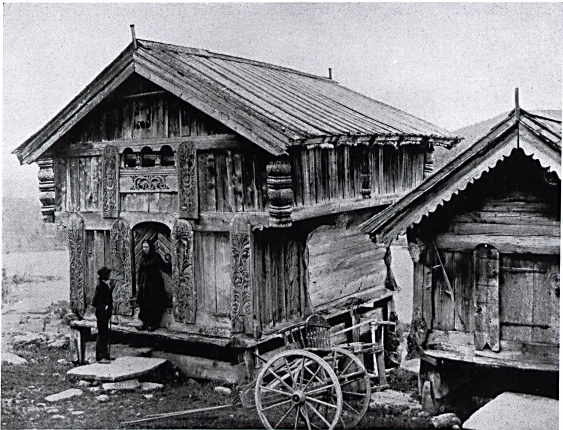
Abb. 385: Stabur (Speicher) aus Telemarken. Das am Saume mit der Säge verzierte Windbrett am rechten Beispiel bildet eine spätere Zutat und fällt aus dem Rahmen nordischen Gestaltens.
