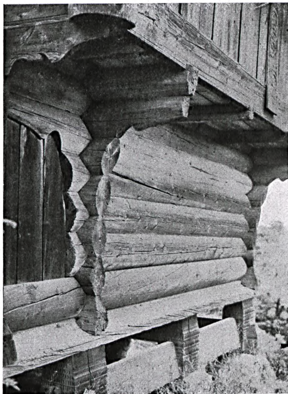
Abb. 71: Teilansicht von einem Speicher aus Telemarken (Norwegen) mit im Querschnitt oval beschlagenen Ganzhölzern. Der Kern liegt jeweilig in der Mitte. An einem widersonnigen, drehwüchsigen Blockbalken, dem dritten von oben, haben sich die Schwindspannungen so stark ausgewirkt, daß der Riß sich zur Kluff erweiterte. Dieser Riß kann aber auch beim Auseinandernehmen und Übertragen des Bauwerkes aus Norwegen nach Skansen, Stockholm, entstanden sein. Die Fugen sind oben und unten dicht. Hingegen erscheinen an dem über der Schwelle liegenden, nachsonnigen, drehwüchsigen und von Rissen durchzogenen Blockbalken die Fugen gelockert.
