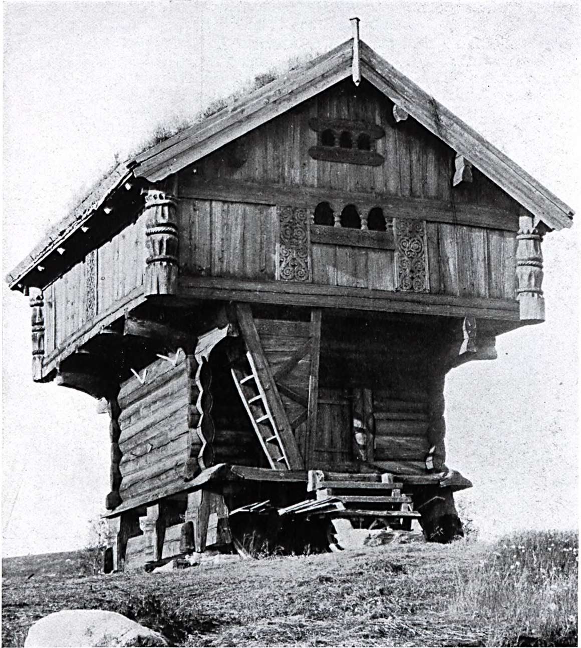
Abb. 388: Stabur aus Telemarken. (Aufnahme von Neupert, Oslo.) Ein kennzeichnendes Beispiel für die weite Anwendung der Saumprofile, die sogar in das Hirnholz übergreifen.
