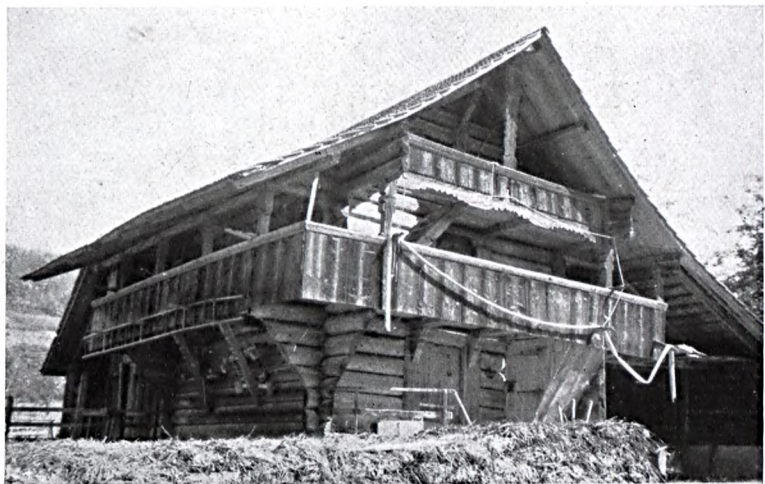
Abb. 409: Speicher vom Lüthihof, Waldhaus, dessen Seitenlaube mit Streben gestützt ist.
