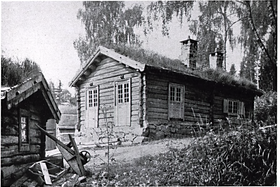
Abb. 382: Das Fjeldgardhaus aus Gudbrandsdalen, jetzt im Freilichtmuseum in Lillehammer. (Aufnahme von Neupert, Oslo.) Die Fenster kommen erst mit dem Kamin, also verhältnismäßig spät, in das nordische Haus. Die Abdeckung der Schornsteine mit einer dünnen Steinplatte und einem Belastungsstein ist kennzeichnend für Norwegen.
