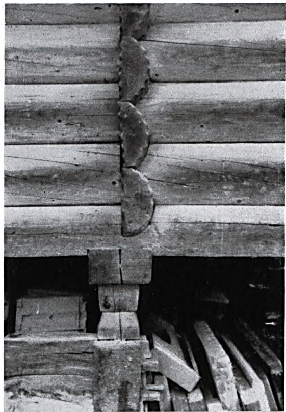
Abb.72: Teilansicht von einem Speicher aus Waldhaus, Kanton Bern, aus gespaltenen und miteinander verschränkten Halbhölzern. An den Schwundrissen kennzeichnet sich der Gerad- oder Drehwuchs des Holzes.
