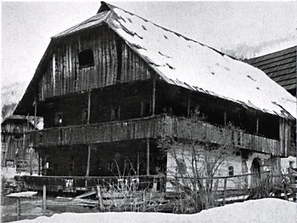
Abb. 344: Bauernhaus aus St. Oswald in Kärnten. Die stumpf aneinanderstoßenden Bretter ließ man am Giebel und an der Brüstung als Schmuck zum Teil über den unteren Saum weiterwachsen und schnitt hier einzelne am Übergang schwalbenschwanzförmig aus.
