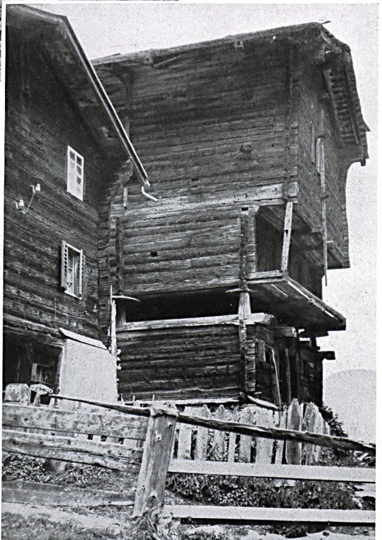
Abb. 415: Speicher mit als Stall dienendem Untergeschoß und drei Stockwerken aus Münster im Wallis. Giebel und Längswände sind durch Zangen gesichert worden.
