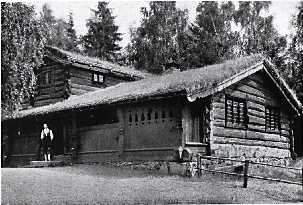
Abb. 110: Ramloftstube vom Hjeltarhof aus Gudbrandsdalen, jetzt in dem Sandvigschen Freilichtmuseum in Lillehammer, aus dem Jahre 1565 mit Sodendach. Ram = Raum über dem Flur, Loft = zweistöckiger, unheizbarer Bau. Im Loft werden Betten aufgeschlagen (Bettloft, Schlafloft). Nach einer Aufnahme von Neupert, Oslo.
