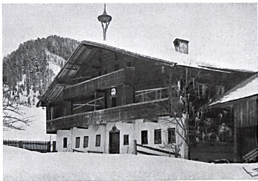
Abb. 321: Bauernhaus aus der Forstau, Salzburg. Beide Brüstungen werden durch schlanke Säulen vor dem Umkippen gesichert, die an Pfetten, Konsolen und einem vereinzelt vorkragenden Blockbalken ihren Halt finden.
