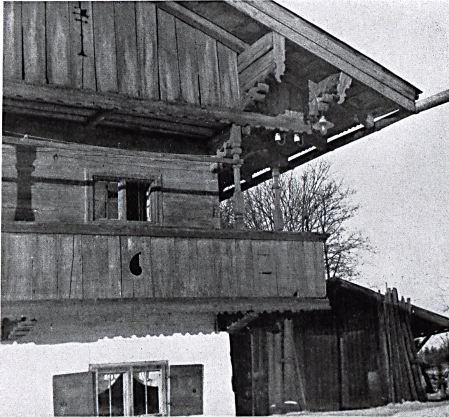
Abb. 341: Ecklösung der Brüstung eines Bauernhauses bei Gmund. An der Sechs erkennt man die Gefahren, denen ein zerschnittenes Brett ausgesetzt ist, wenn man in der Schnittlinienführung auf das Werfen und Spalten nicht genügend Rücksicht nimmt.
