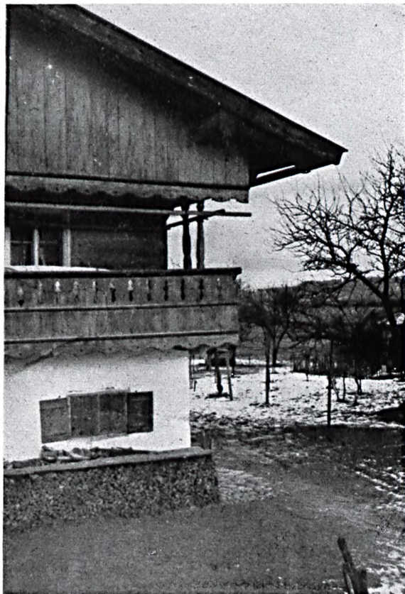
Abb. 333: Verschalte Brüstung von einem Bauernhaus aus Greiling bei Tölz.
