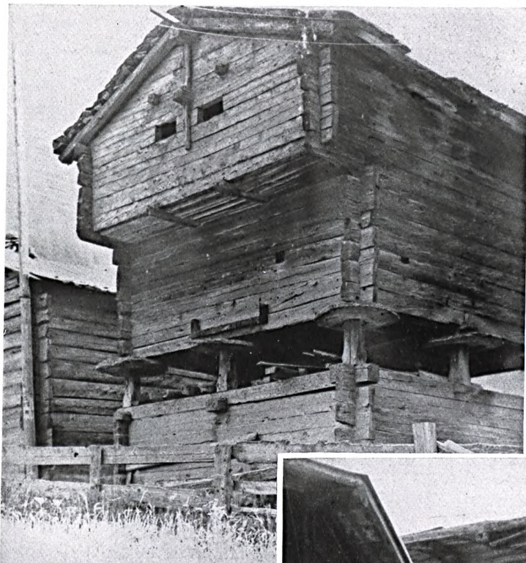
Abb. 414: Speicher mit Untergeschoß und vorkragendem Dachgeschoß aus Münster im Wallis. Die Giebelwand ist durch eine Zange gesichert.
