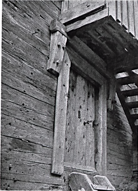
Abb. 269: Tür von einem Getreidekasten aus Hofgastein. Die angenagelten Konsolen sind in ihrem unteren Drittel versetzt. Die darauf ruhende Schwelle ist auf die Konsolen aufgezapft.
