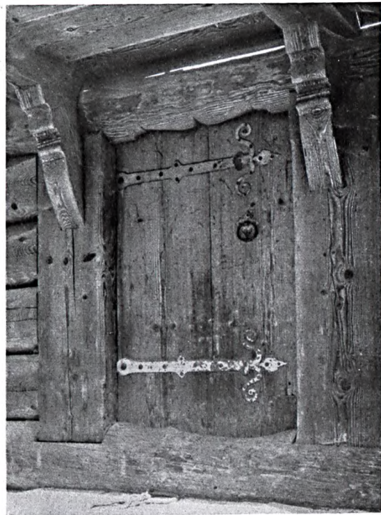
Abb. 237: Speichertür aus Waldhaus, Kanton Bern
