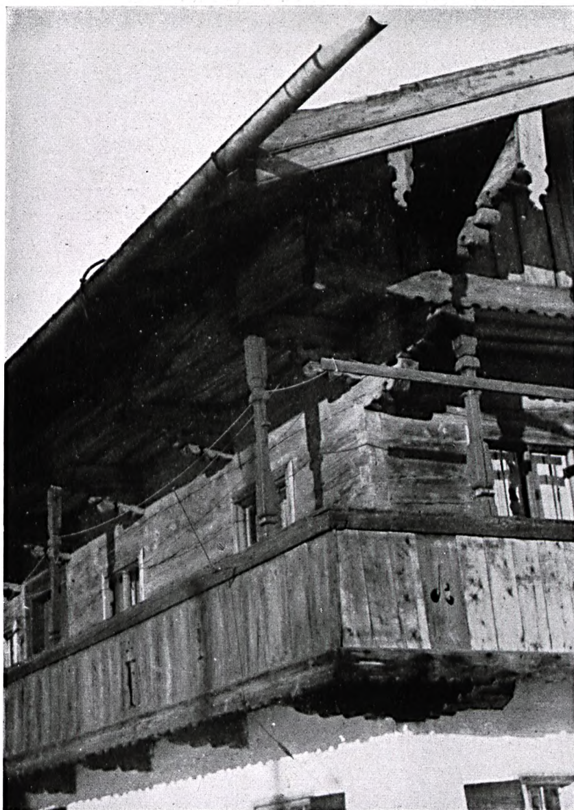
Abb. 340: Ecklösung der Brüstung eines Bauernhauses bei Gmund. Die herausgesägten Zierformen und Zahlen liegen inmitten der Schalbretter. Dadurch konnte man in der Zeichnung sich weiter entfalten, als wenn die Form durch eine Stoßfuge zerschnitten worden wäre.
