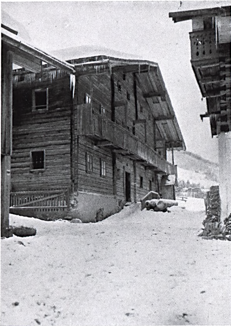
Abb. 320: Bauernhaus aus der Forstau, Salzburg. Die Brüstung wird von Säulen, die an vorkragende Blockbalken angeblattet sind, vor dem Umkippen bewahrt. (Vgl. Abb. 319/1.)
