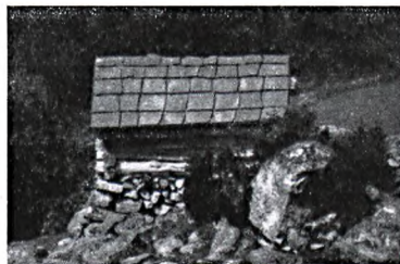
Abb. 163: Steindächer aus Gneisplatten aus dem Tessin (links nach Gladbach). Durch das große Eigengewicht und dadurch, daß die einzelnen Platten fast waagrecht liegen, bedarf diese Dachdeckung keiner weiteren Sicherung.
