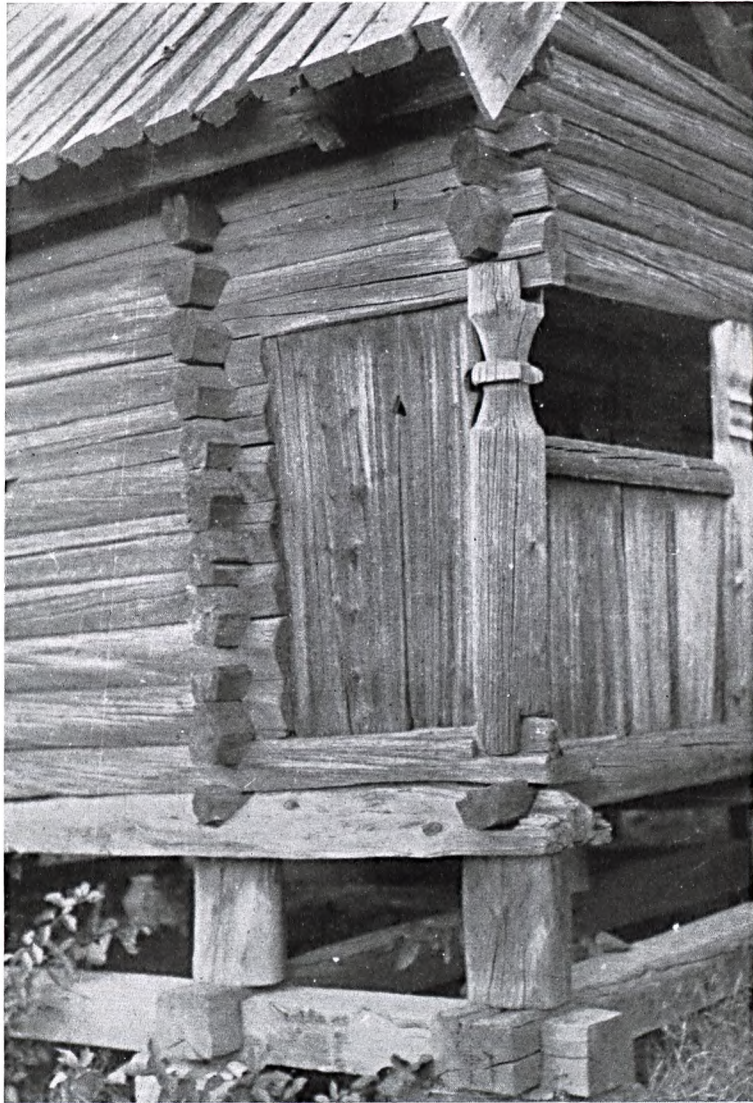
Abb. 359: Eckansicht vom mittelalterlichen Pfostenspeicher des Aelvroshofes, jetzt in Skansen, Stockholm. Die Stützen an der Vorlaube zeigen eine runde und eine vierkantige Grundform, die bei beiden durch Zurückarbeiten und Aussparen eines Teiles aus der Mitte geschmückt worden sind. Während die Ecksäulen mit Schlitzfenstern eingefügt worden sind, greifen die Mittelstützen in Anlehnung an die Türpfosten mit Zapfen ein.
