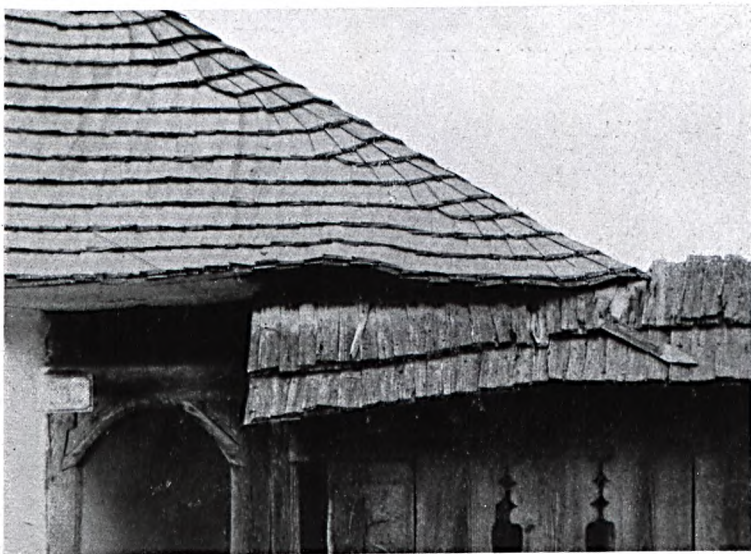
Abb. 147: Schindeldächer mit genuteten Schindeln aus dem Siebenbürgischen Erzgebirge. Um an der Traufe die Dachhaut dicht zu halten, liegt hier eine doppelte Reihe von Schindeln. Am Grat hat man Schindeln gewöhnlicher Ausmaße benutzt und sie nur mit dem Ziehmesser an der schmalen Kante nach oben zu zurückgearbeitet. Dadurch wurde am Saum in den Schindel-
