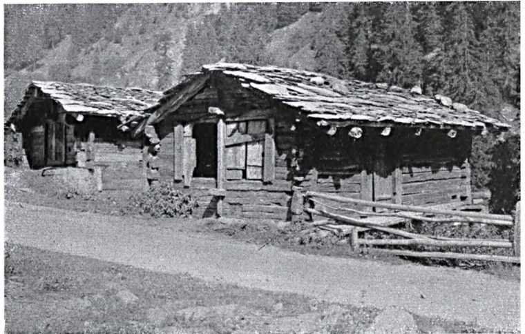
Abb. 162: Heustadel mit Steindächern aus Kippel am Lötschberg im Wallis. An dem in ursprünglicher Art mit Gneisplatten gedeckten Dach hat man, weil die Platten nur eine behelfsmäßige Bearbeitung aufweisen, noch mit Holzschindeln geflickt.
