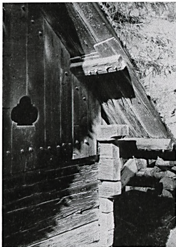
Abb. 131: Teilansicht von einer Mühle aus Ebene Reichenau, Kärnten, wo sowohl die Dachschindeln als auch die Schalbretter mit Holznägeln befestigt worden sind.
