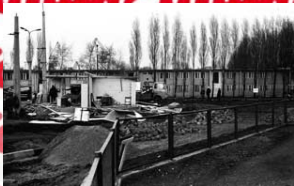
Gdańsk, budowa pomnika Poległych Stoczniovców, 1980 r.
