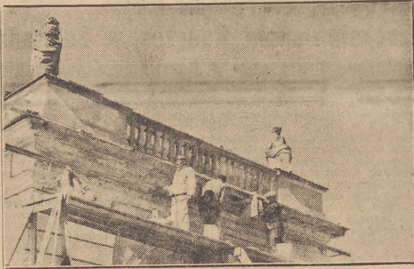
Remont pałacu w Łazienkach
