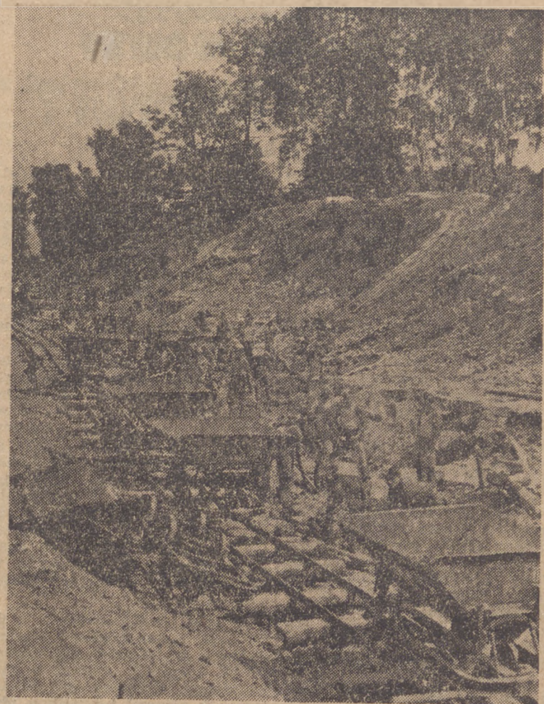
Prace przy budowie linii kolejowej Olkusz — Mysłowice trwają. Dzielni kopalnie Zagłębia Węglowego będą zaopatrywane w piasek do podszadzki z Pustyni Błędowskiej. Na zdjęciu widzimy junaków „Służby Polsce” przy pracy. (Fot. APD)
