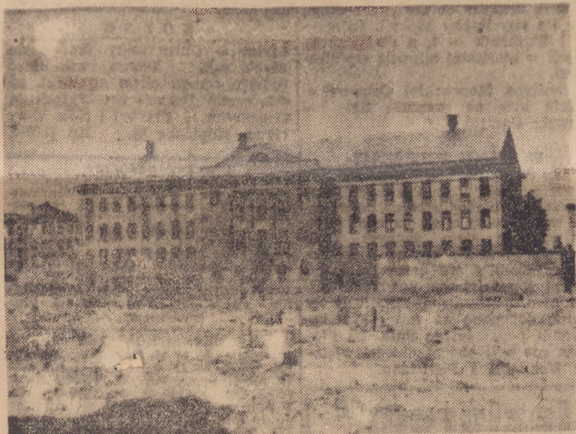
Wielki gmach Hipodromu stoi dzisiaj przy rozkopanym placu. Za rok będzie się tędy wjeżdżał w wykop tunelu W-Z.
