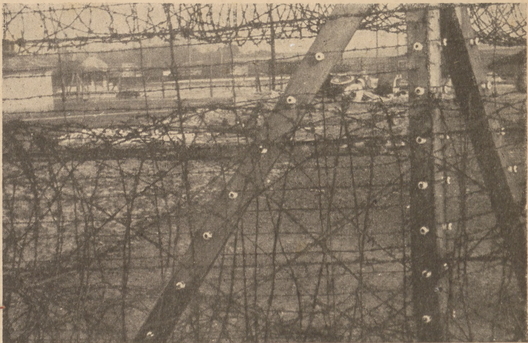
Więzienie w Poznaniu. Przewody wysokiego napięcia
